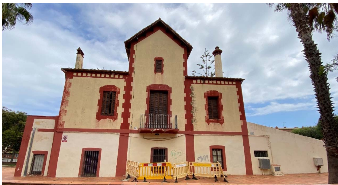
Façana posterior (nord) – vista frontal
