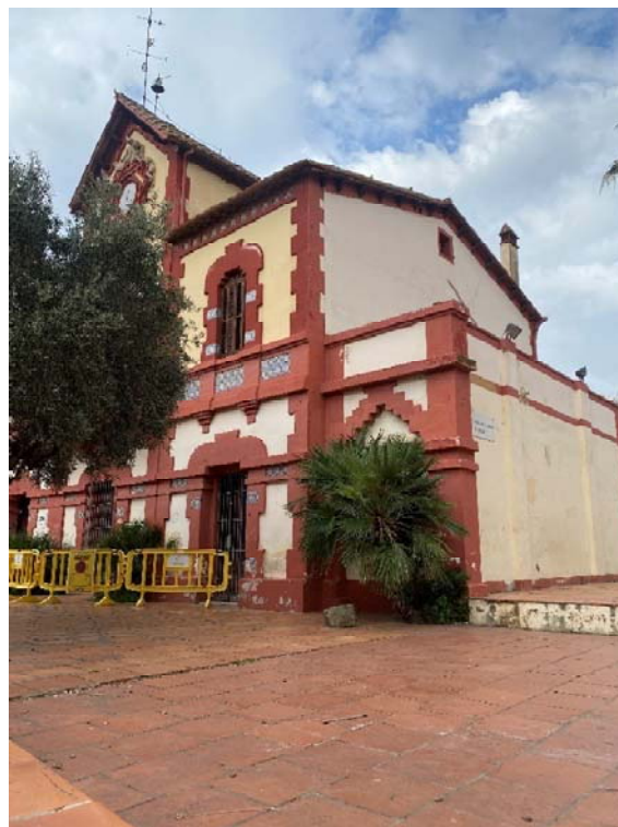
Façana principal (sud) – vista del lateral sud-est
