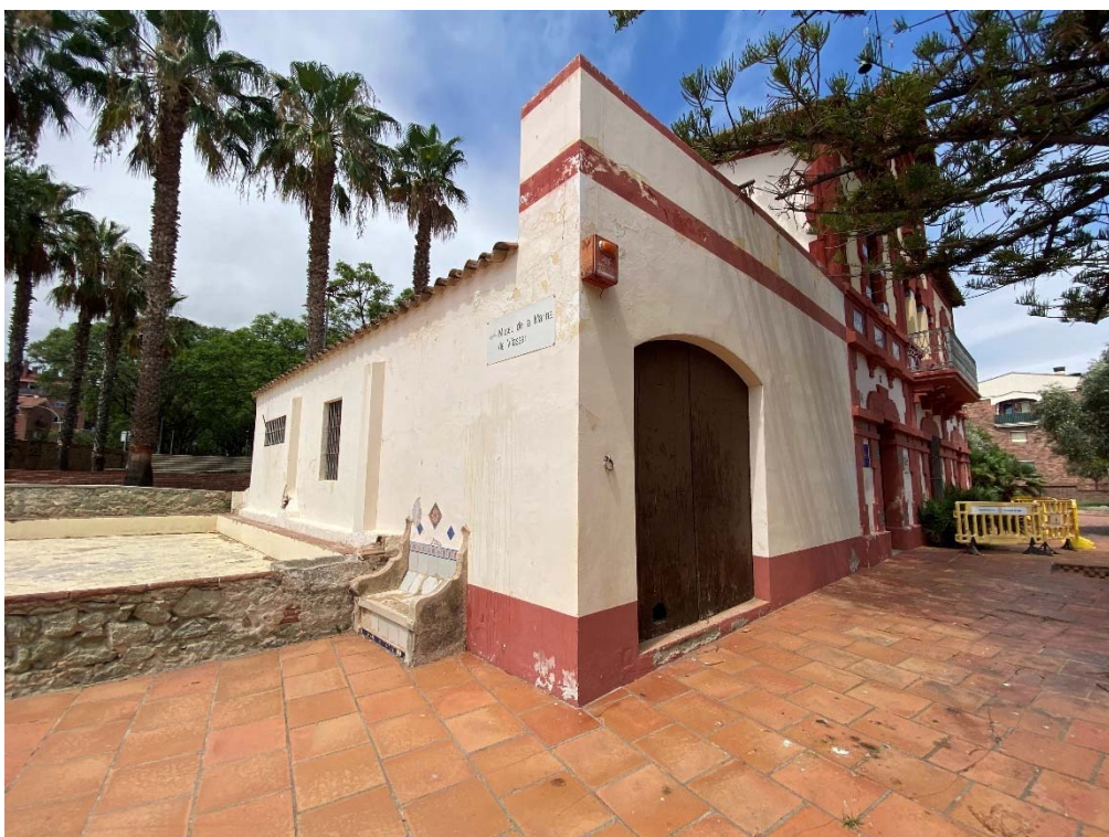
Façana lateral (oest) – vista del lateral sud-oest
