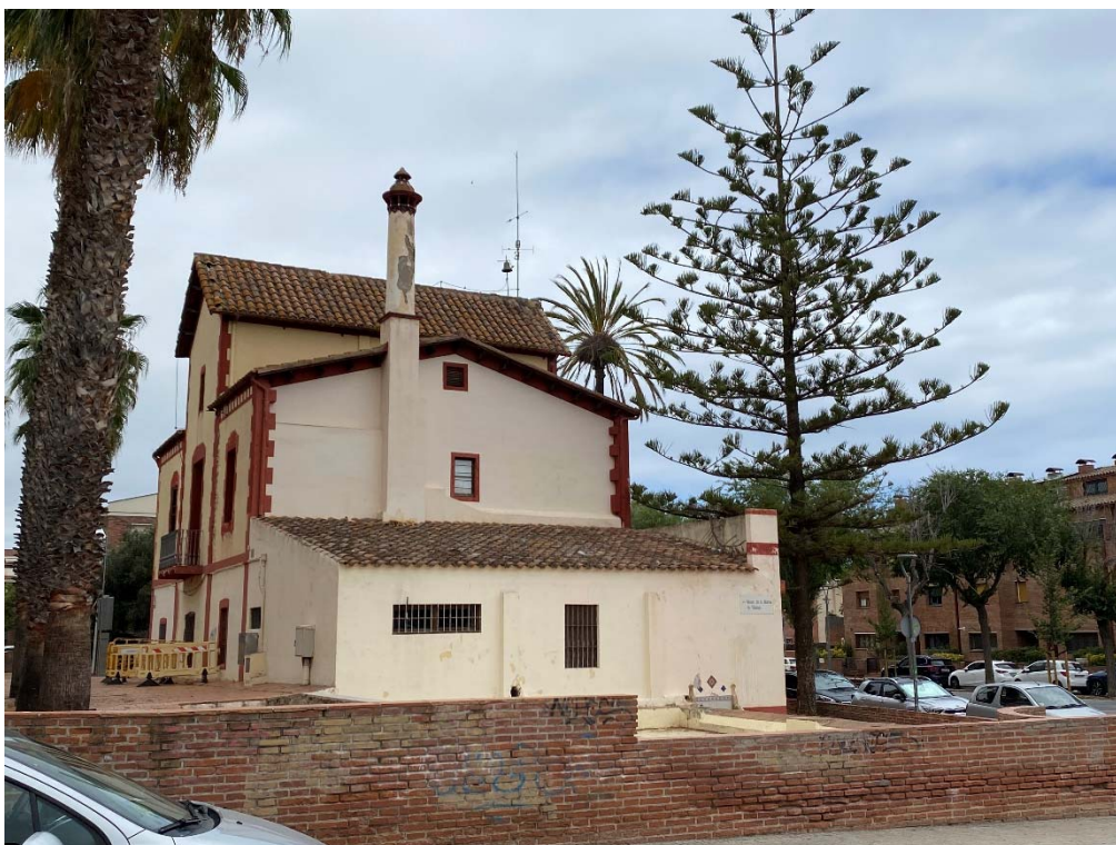
Façana lateral (oest) – vista del lateral nord-oest
