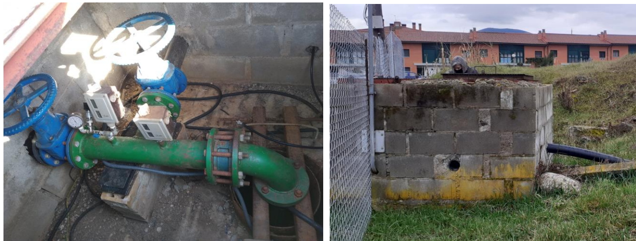
Figura 3. Interior i exterior de l'actual pou de Cabanau
