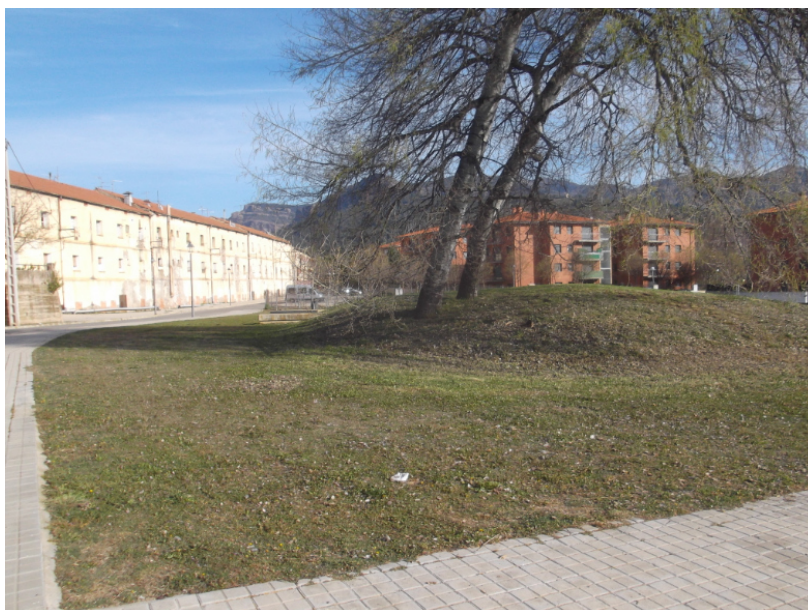
Figura 2.4.- Detall del nivell de reblerts existents a la zona analitzada i que podria presentar un gruix de fins a 2 m (Fotos: 25/03/21)
