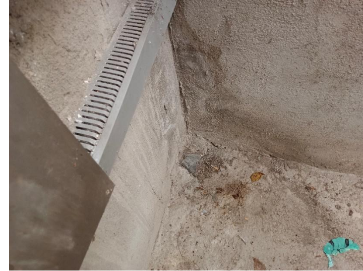
Imatge 6. Interior fossat ascensor
