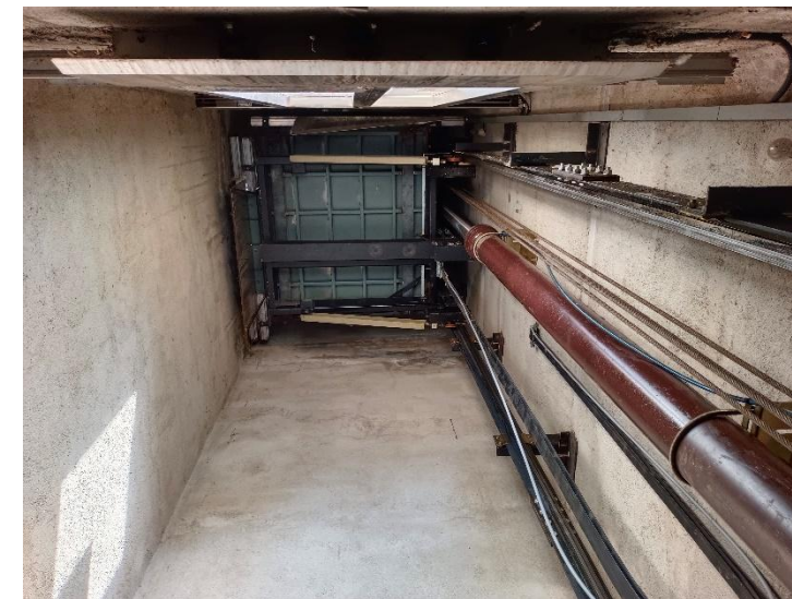
Imatge 3. Vista interior caixa ascensor
