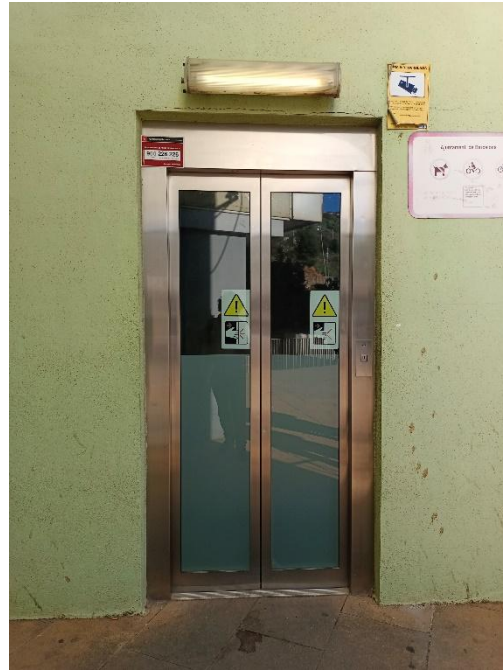
Imatge 7. Accés nivell superior carrer de Vila-real
