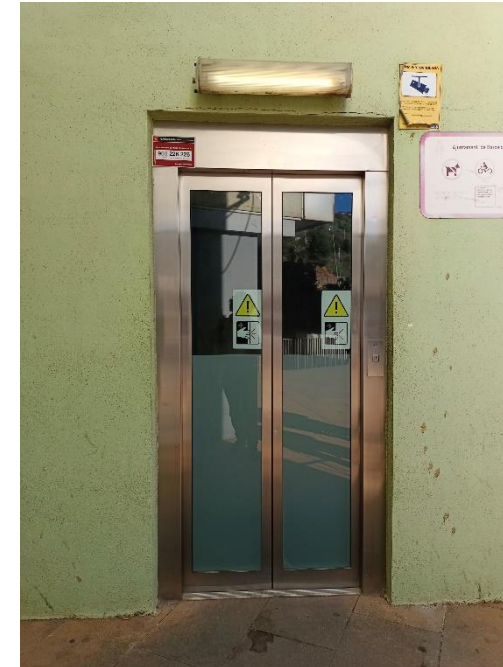
Imatge 7. Accés nivell superior carrer de Vila-real
