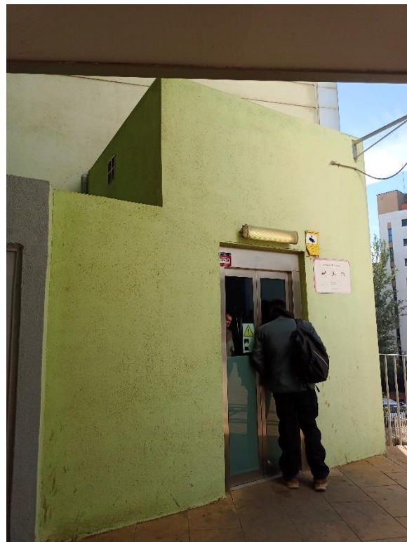
Imatge 3. Vista general ascensor 015A carrer d'Aiguablava – carrer de Vila-real
