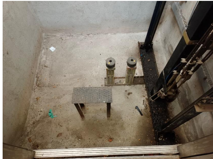
Imatge 5. Interior fossat ascensor
