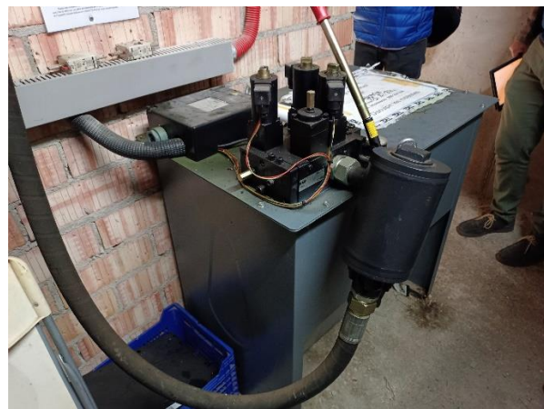
Imatge 12. Central hidràulica existent
