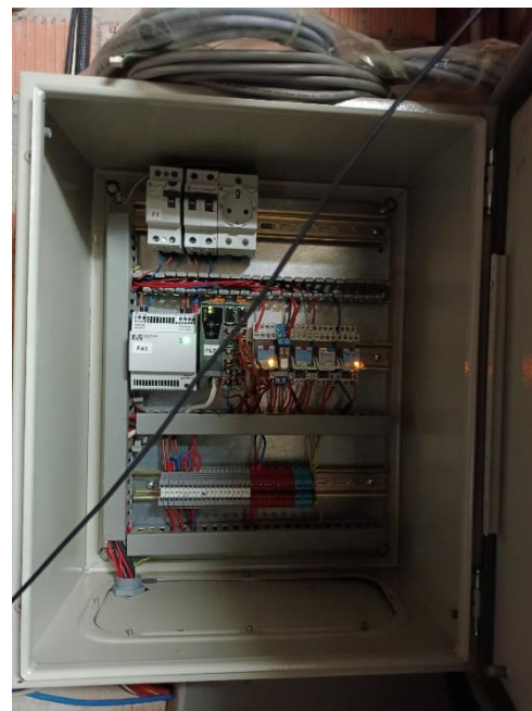
Imatge 13. Maquinària ascensor en sala de màquines
