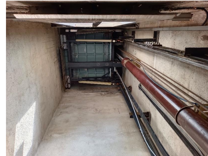
Imatge 4. Vista interior caixa ascensor
