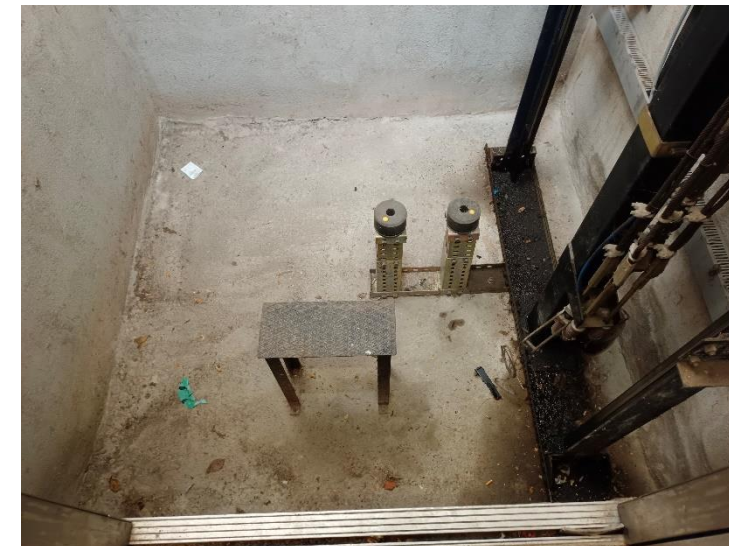
Imatge 5. Interior fossat ascensor
