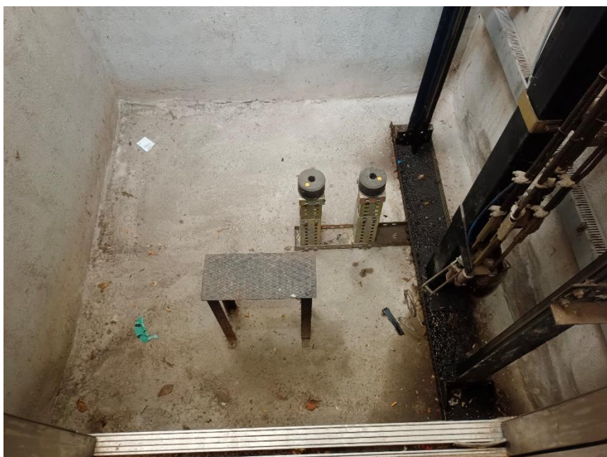
Imatge 5. Vista interior fossat ascensor
