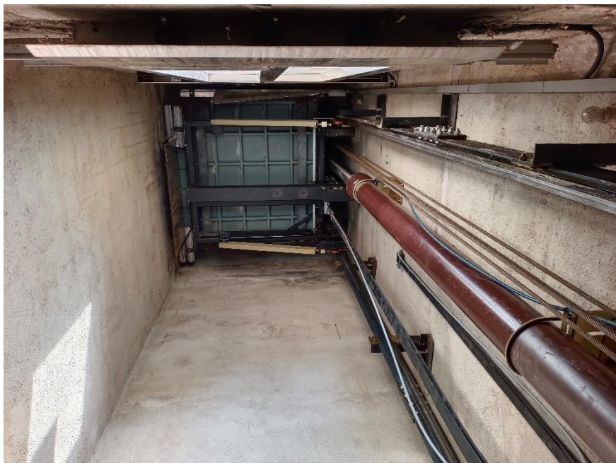
Imatge 4. Vista interior estructura caixa ascensor (des de Planta Baixa)
