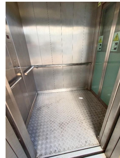
Imatge 15. Vista interior cabina existent ascensor amb doble embarcament a 90º
