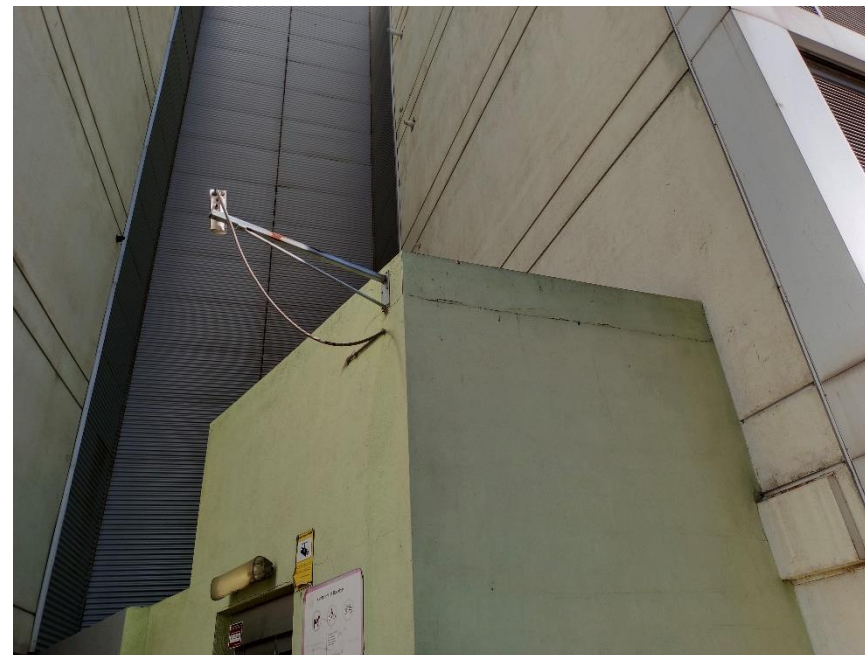
Imatge 6. Vista exterior coberta edicle d'obra existent
