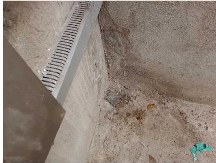
Imatge 6. Interior fossat ascensor
