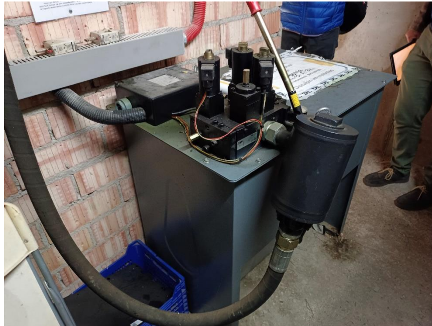
Imatge 12. Central hidràulica existent
