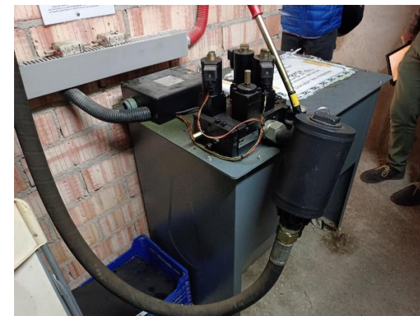
Imatge 12. Central hidràulica existent
