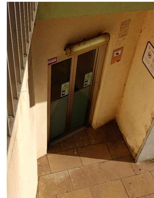
Imatge 8. Accés nivell intermedi entre carrers
