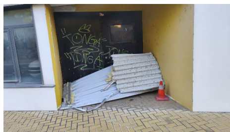
Trams de coberta en procés d'arrencament durant la ventada i intervenció dels bombers.
