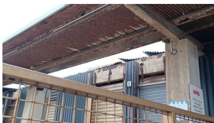
Trams de coberta amb elements despresos i fixacions i elements estructurals descoberts amb un elevat estat de corrosió
