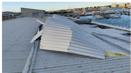
Trams de coberta en procés d'arrencament durant la ventada i panell de de coberta propulsat pel vent
