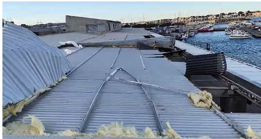
Trams de coberta en procés d'arrencament durant la ventada i panell de de coberta propulsat pel vent
