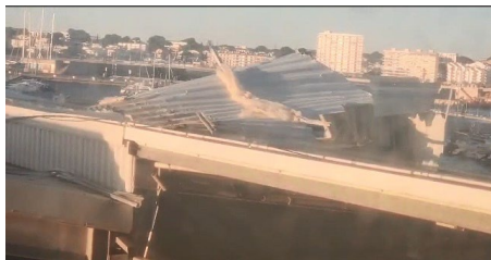
Trams de coberta en procés d'arrencament durant la ventada i intervenció dels bombers.
