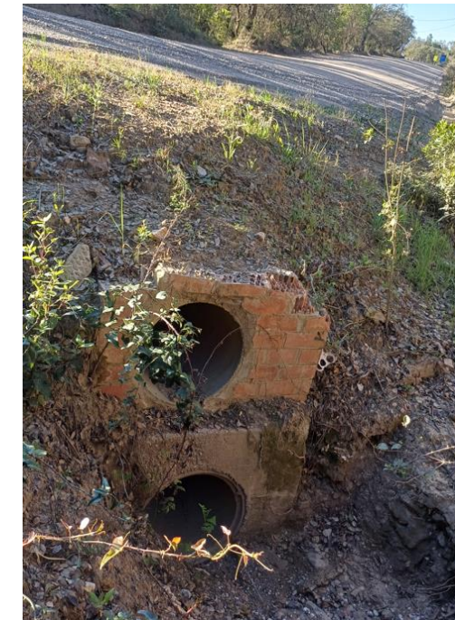
Figura 6. Fotografia estat actual broc creuament d'aigua.
