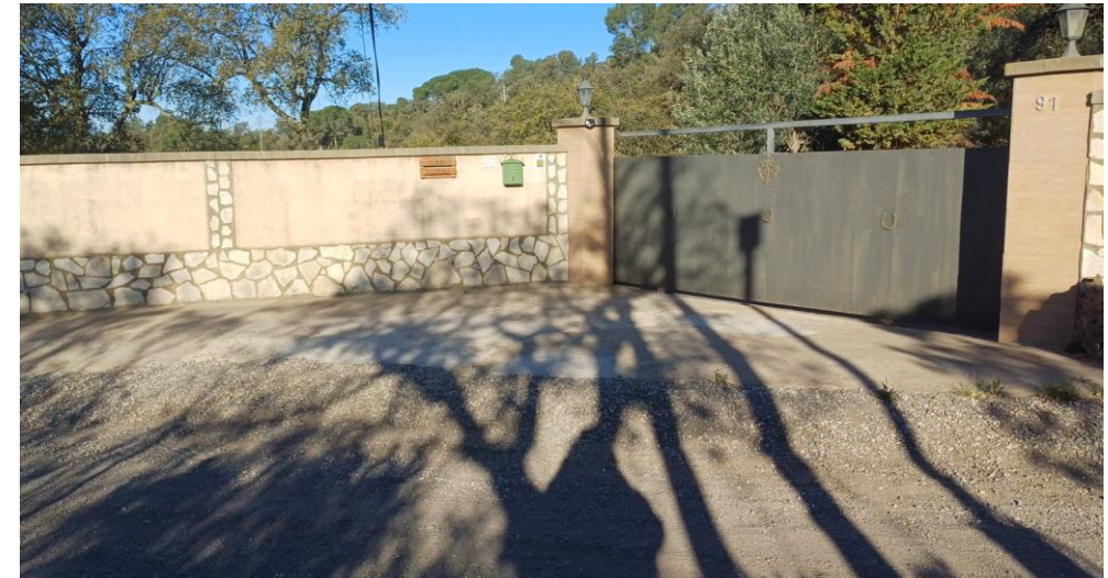
Figura 11. Fotografia estat actual entrada del Camí dels Metges a la finca 91.
