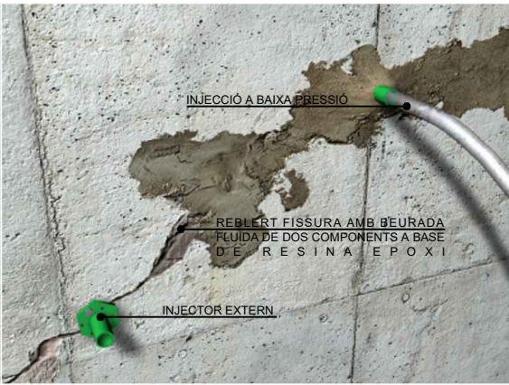
DETALL INJECCIÓ FISSURA
