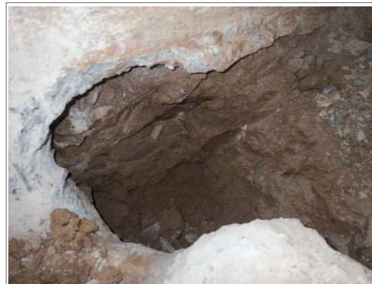
Fotografia 4: Terreny de recolzament de sabata i riostra
