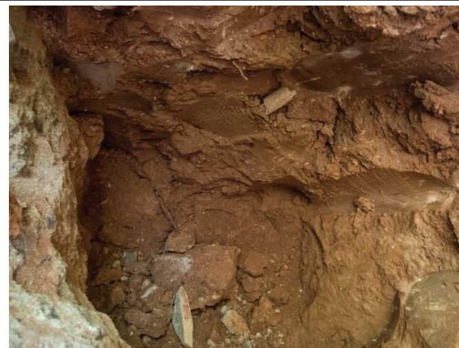
Fotografia 5: Detall del nivell Q (argiles) de fonamentació
