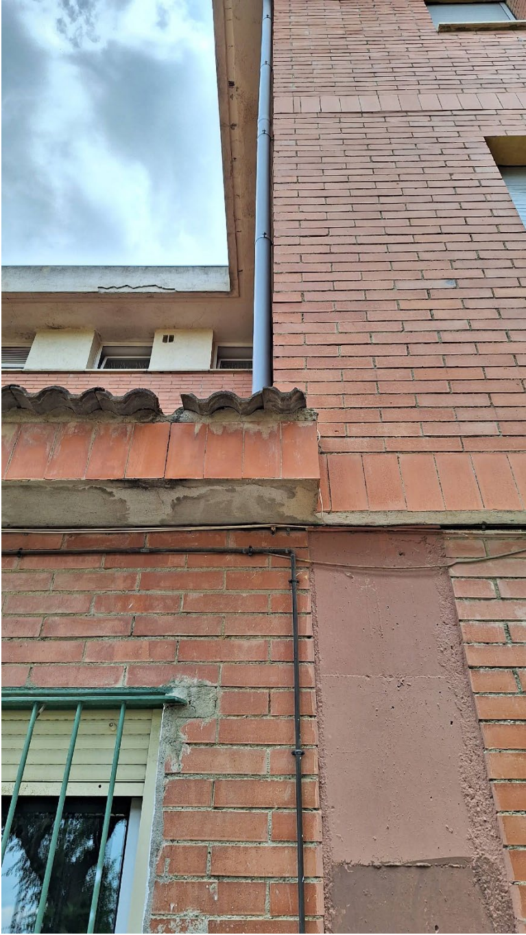
Imatge 5 - Detall façana oest escola
