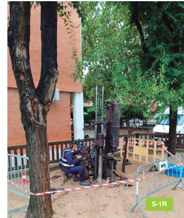
Figura 4. Emplaçament del sondeig a rotació S-1R.
