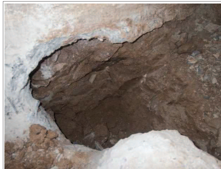
Fotografia 4: Terreny de recolzament de sabata i riostra
