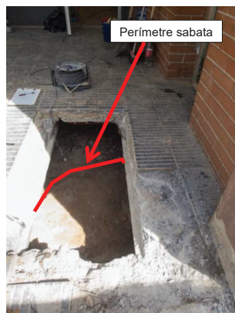
Fotografia 2: Detall de la cala amb el forjat sanitari i traça de la sabata
