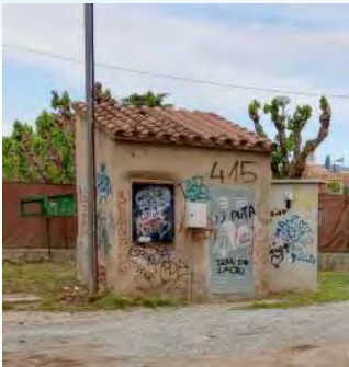
Pou Piscines, caseta del pou.
