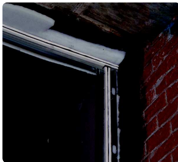
Trasdosado y techo aislante con LA.
