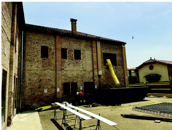
Façana del pati interior (orientació oest). Juny 2024
