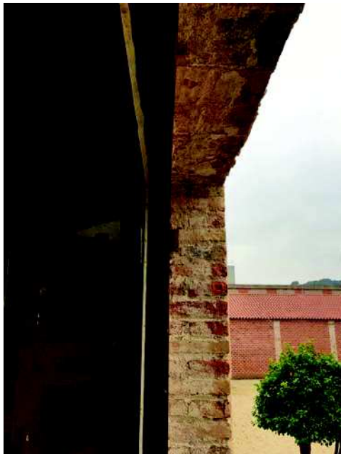
Foto 11. Llinda d'obra amb maó massís manual i ampit amb cavitat del radiador i escopidor amb peces de rajola esmaltades malmeses.
