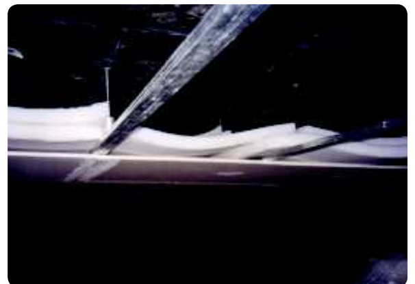
Techo aislante con PKB-2.
