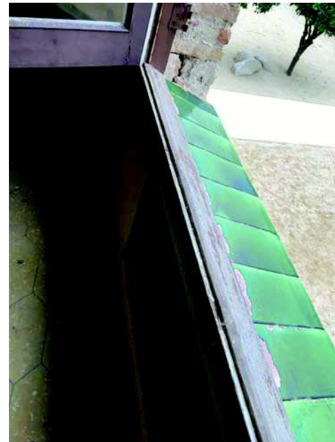
Foto 11. Llinda d'obra amb maó massís manual i ampit amb cavitat del radiador i escopidor amb peces de rajola esmaltades malmeses.
