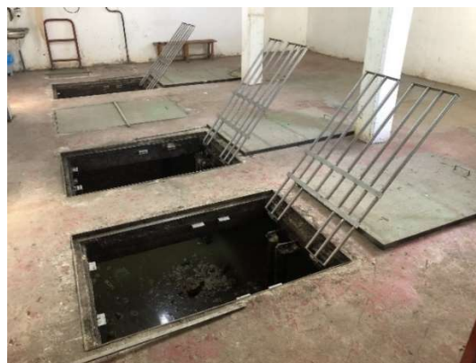
Figura 10. Les reixes a instal·lar han de permetre la seva obertura total en cas de necessitat d'accedir al pou
