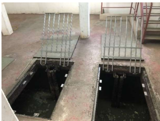
Figura 10. Les reixes a instal·lar han de permetre la seva obertura total en cas de necessitat d'accedir al pou
