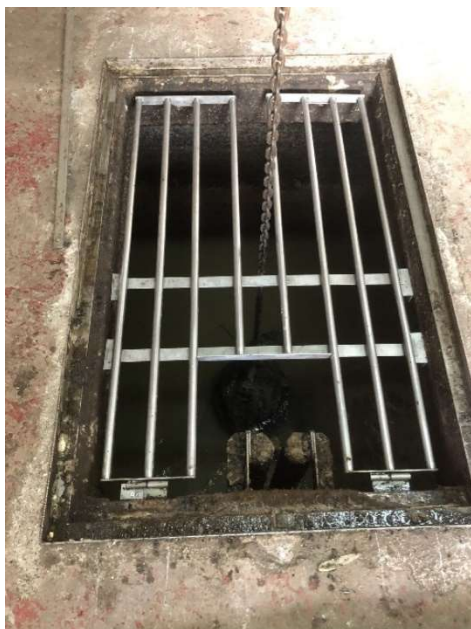
Figura 11. A l'esquerra, preparació del sistema de retirada de la bomba mitjançant cadena del polispast. A la dreta, obertura de la reixa i retirada de la bomba del pou. Cal que les noves reixes antigaigudes garanteixin aquesta operativa.
