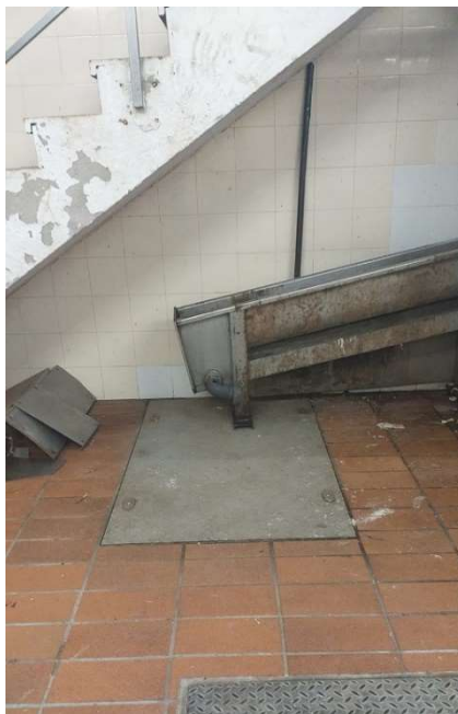
Figura 8. Vista de la tapa d'accés a càmera estabilitzadora
