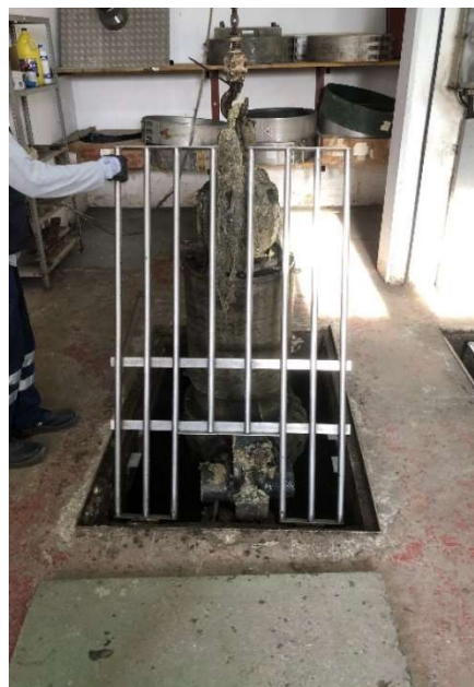
Figura 11. A l'esquerra, preparació del sistema de retirada de la bomba mitjançant cadena del polispast. A la dreta, obertura de la reixa i retirada de la bomba del pou. Cal que les noves reixes antigaigudes garanteixin aquesta operativa.
