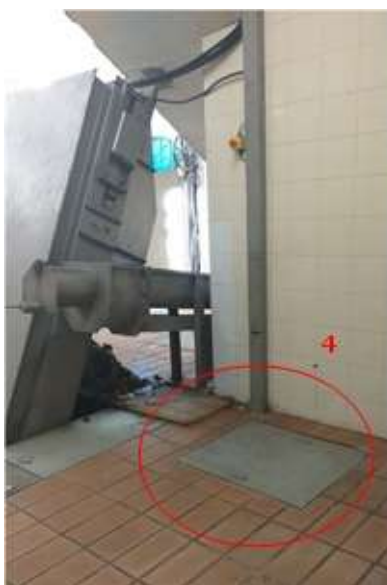
Figura 7. Vista de la tapa d'accés al pou d'aigües pluvials (assenyalada amb el núm. 4)
