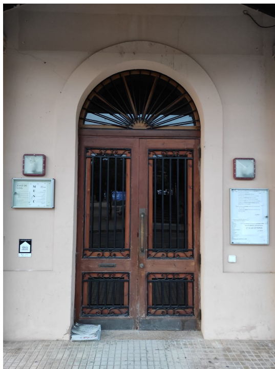
07_Portes principals (reparació), 3 ut
