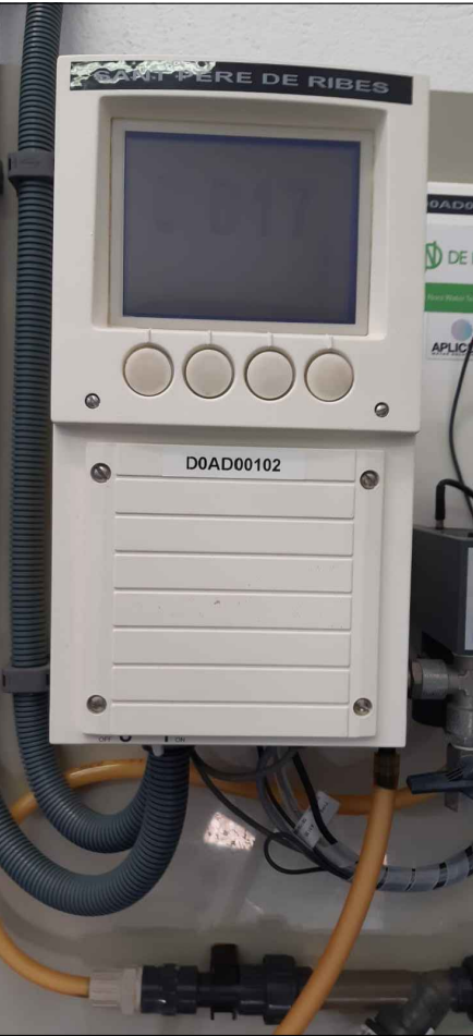
ANALITZADOR DE CLOR DIPÒSIT COSTA A SANT PERE DE RIBES MATRICULA D0AD00102
