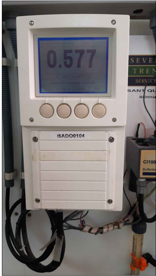
ANALITZADOR CLOR SORTIDA SQRDC DIPÒSIT C-250 SANT QUIRZE MATRICULA I6AD00104
