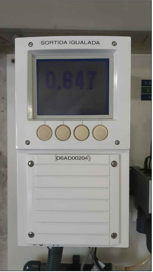
ANALITZADOR CLOR LLIURE RESIDUAL SORTIDA DIP. 2 PIERA MATRICULA D6AD00204
