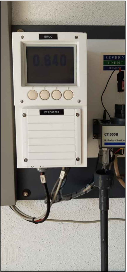
ANALITZADOR DE CLOR SORTIDA HOSTALETs MATRICULA E7AD00202
