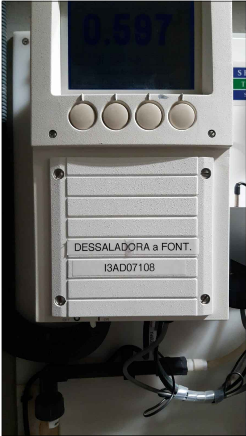
ANALITZADOR DE CLOR DESSALINITZADORA A DIPÒSIT FONTSANTA MATRICULA I3AD07108
