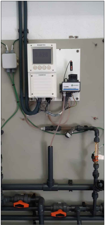
ANALITZADOR DE CLOR DIPÒSIT COSTA A ROQUETES MATRICULA D0AD00103
