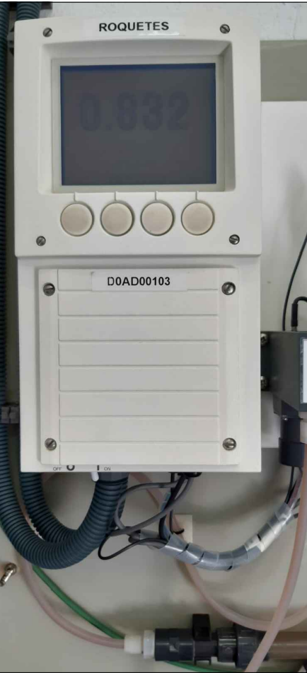
ANALITZADOR DE CLOR DIPÒSIT COSTA A ROQUETES MATRICULA D0AD00103
