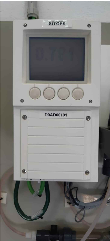
ANALITZADOR DE CLOR DIPÒSIT COSTA A SITGES - MATRICULA D0AD00101
