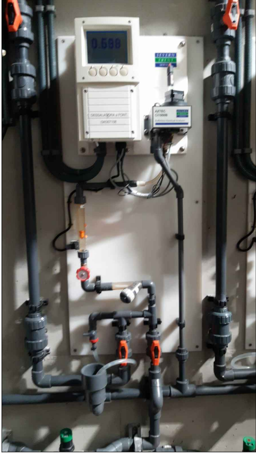
ANALITZADOR DE CLOR DESSALINITZADORA A DIPÒSIT FONTSANTA MATRICULA I3AD07108
