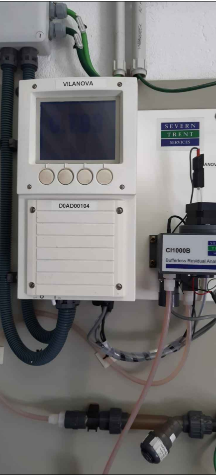
ANALITZADOR DE CLOR DIPÒSIT COSTA A VILANOVA I LA GELTRÚ MATRICULA D0AD00104
