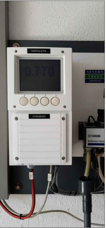
ANALITZADOR DE CLOR ENTRADA DIPÒSIT HOSTALET MATRICULA E7AD00201
