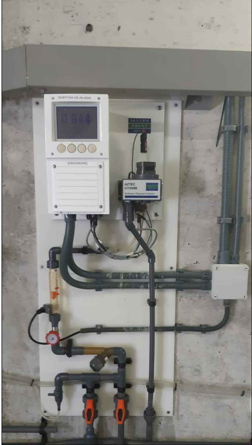
ANALITZADOR CLOR LLIURE RESIDUAL SORTIDA DIP. 2 PIERA MATRICULA D6AD00204
