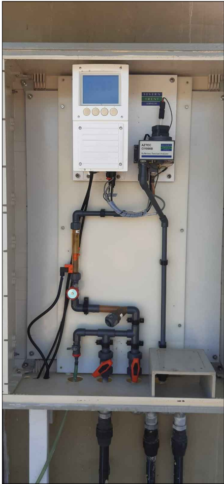
ANALITZADOR DE CLOR DIPÒSIT COSTA DIPÒSIT COSTA MATRICULA D0AD00105
