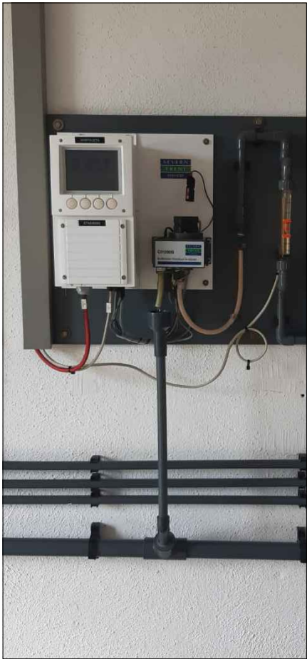
ANALITZADOR DE CLOR ENTRADA DIPÒSIT HOSTALET MATRICULA E7AD00201
