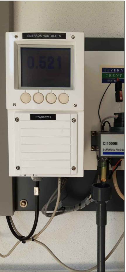
ANALITZADOR DE CLOR SORTIDA E.B EL BRUC MATRICULA E7AD00203
