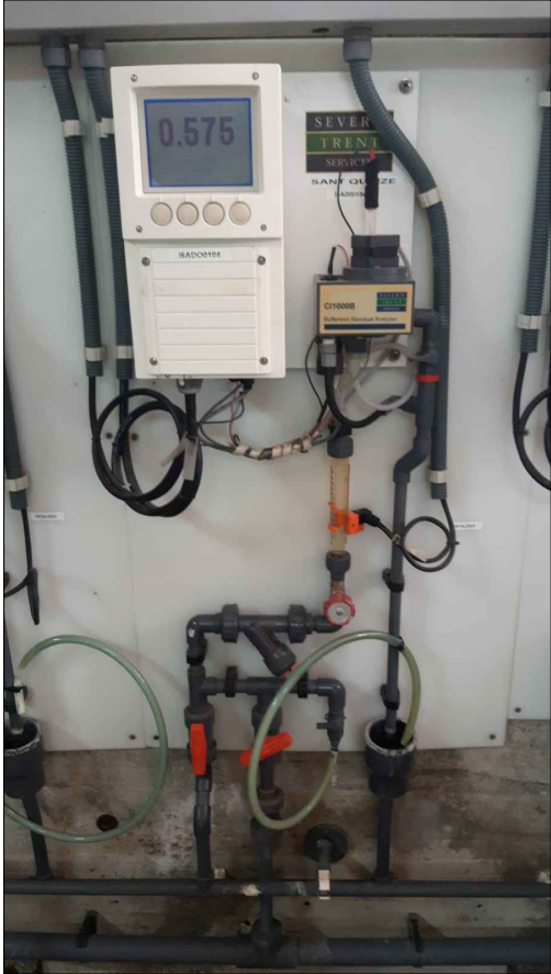
ANALITZADOR CLOR SORTIDA SQRDC DIPÒSIT C-250 SANT QUIRZE MATRICULA I6AD00104
