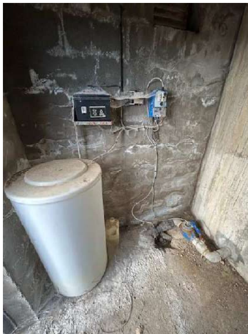
Imatge 05. Estat actual interior caseta existent.
