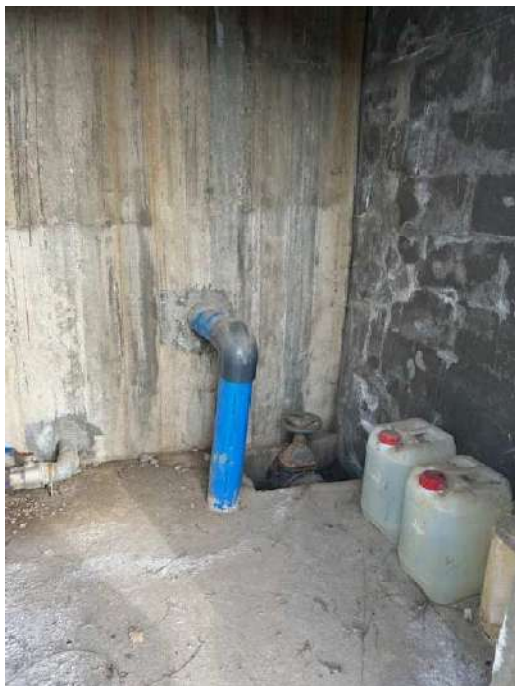
Imatge 04. Estat actual interior caseta existent.
