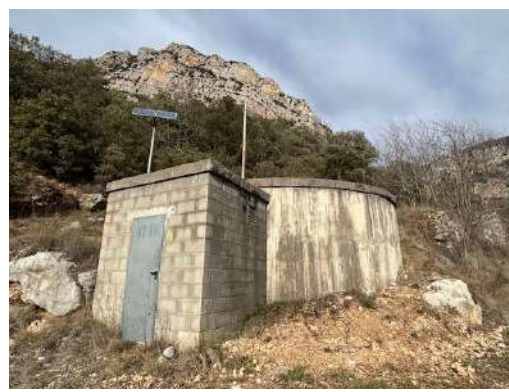
Imatge 07. Estat actual interior caseta existent.
