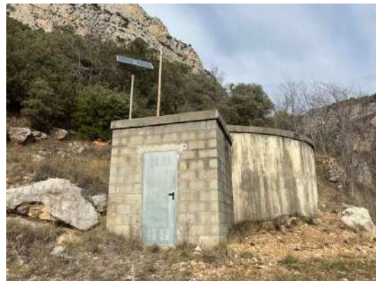
Imatge 02. Estat actual del dipòsit de Montanisell. Caseta.
