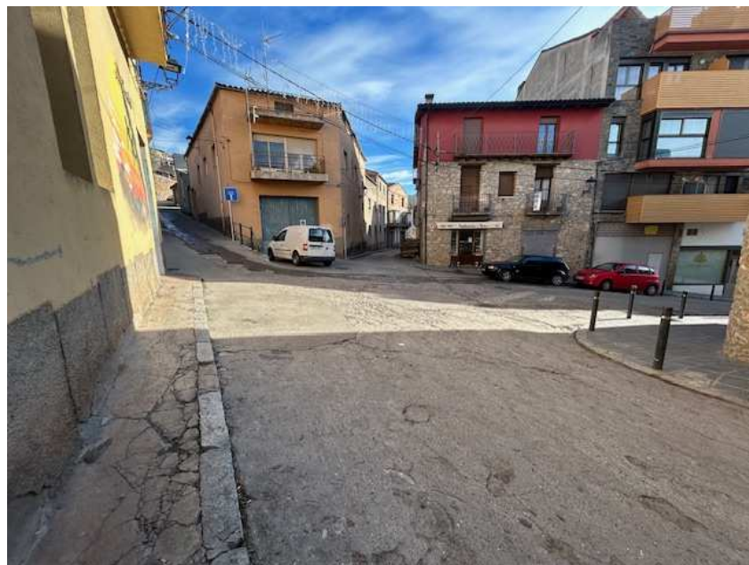
Imatge 08. Estat actual del carrer.
