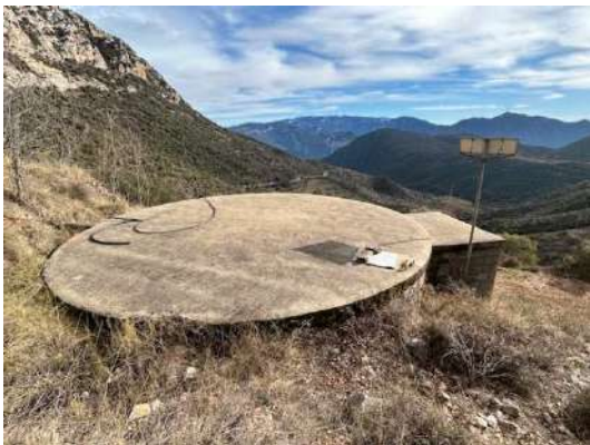
Imatge 01. Estat actual del dipòsit de Montanisell. Coberta.
