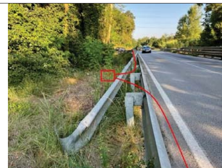
Micro-rasa tipologia ST2a, a la carretera N-141e PK 106+735, amb tipologia ST-2, i Pericó tipus A, al voral (17020PE2428) a l'entrada del pont de la Sèquia de Bescanó
