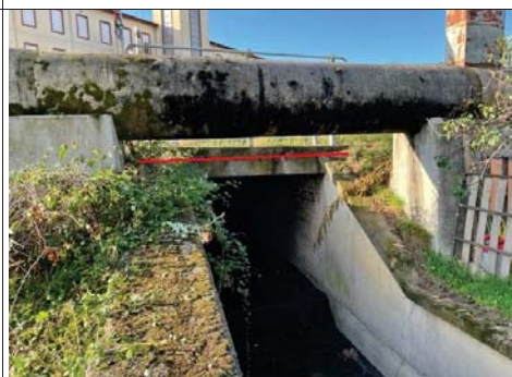
Pas pel pont de sobre el Torrent de la Verneda, amb tub metàl·lic, a la carretera N-141e PK 100+020
