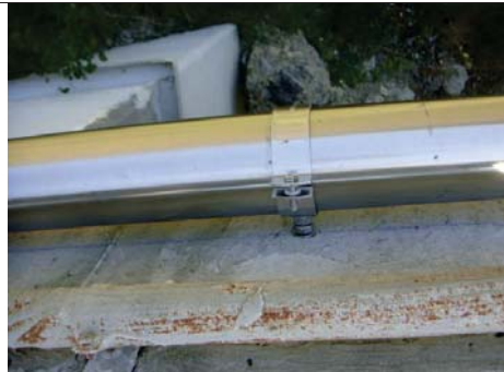
Detall de les brides de subjecció del tub metàl·lic a l'estructura del pont
