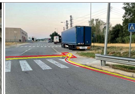
Caixa d'empulament 17020CE01PE2404 a la girola de la Carretera GI-535 PK 0+000
