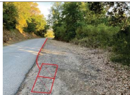
Micro-rasa tipologia ST3a, a la carretera de Vilanna PK 1+135, amb pericó tipus C2, a terres (17020PE2427)
