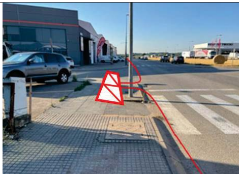
Micro-rasa tipologia ST8, al C/ Caterina Albert cantonada C/ Can Culebra, amb pericó tipus B2, a la vorera (17020PE2401).
