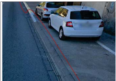
Rasa per damunt la vorera per salvar les reixes de recollida d'aigües
