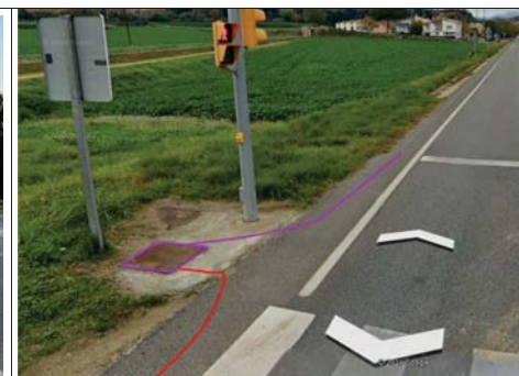
Micro-rasa tipologia ST1 en l'enllaç amb la canalització existent no inventariada a la carretera N-141e PK 112+342, al pericó existent tipus B 17020PE2406
