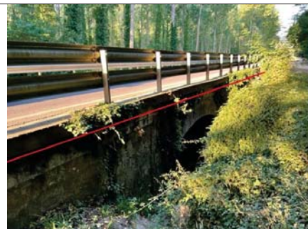
Pas pel pont de sobre el Torrent d'en Ribera, amb tub metàl·lic, a la carretera N-141e PK 105+430
