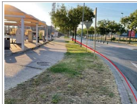
Tram Micro-rasa tipologia ST-8, per rigola, Av de la Pau a l'entrada de la girola amb el C/ Alfons Moré
