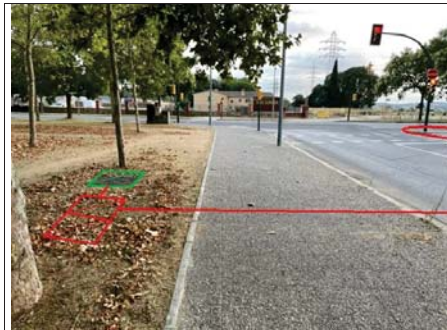
Inici canalització en el pericó existent 17079PE8183 del C/ Montnegre i nou pericó C2 17079PE2437. Connexió amb CC
