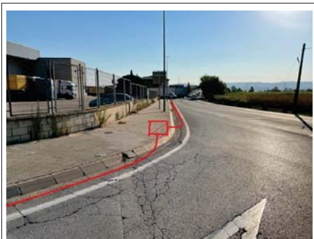
Micro-rasa tipologia ST8, a la carretera de Vilablareix (GIV5332) cantonada C/ Caterina Albert, amb pericó tipus B2, a la vorera (17020PE2400)
