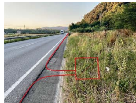
Micro-rasa tipologia ST2a, a la carretera N-141e PK 107+560, amb pericó tipus B2, a terres (17020PE2418)
