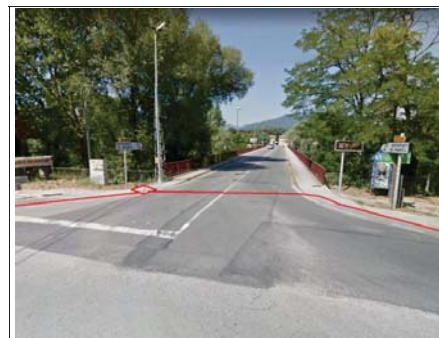
Micro-rasa tipologia ST-1, a la carretera N-141e PK 103+692, amb pericó tipus B2, a terres (17020PE2424). Cruïlla GI-532
