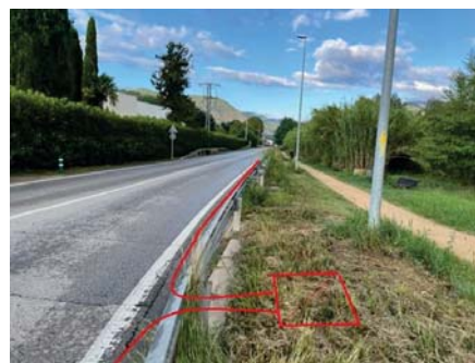
Micro-rasa tipologia ST-4, a la carretera N-141e PK 101+945, amb pericó tipus B2, al voral (17008PE2400)
