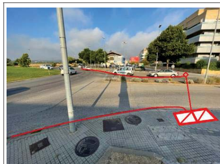
Creuament de l'Av Marqués de Camps amb tipologia ST-7, des de el pericó tipus C2 17155PE2405 al pericó tipus B2 17155PE2406
