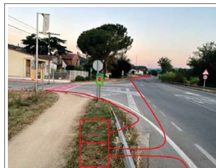
Micro-rasa tipologia ST1 amb Pericó tipus C2, al voral (170020PE2405) a la cruïlla de la carretera N-141e amb l'Av del Mas Pol
