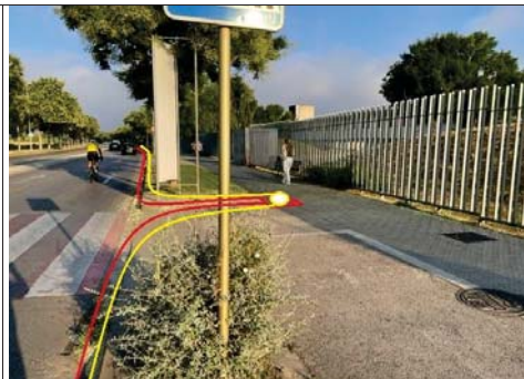
Valona 17155VL01PE2401 en pericó C2 a l'Av de la Pau de salt, davant del Hospital de Santa Caterina
