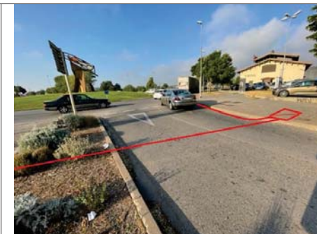
Creuament de l'Av Marqués de Camps amb tipologia ST-7, i Pericó tipus B2 a vorera (17155PE2406) i sortida de la girola pel Camí dels Carlins amb tipologia ST-8 a rigola
