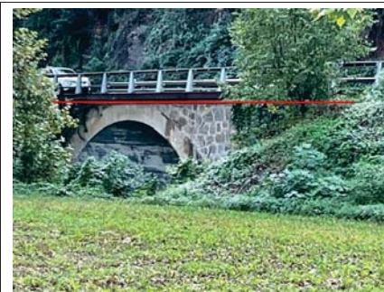
Pas pel pont de sobre la Riera de Sant Pere, amb tub metàl·lic, a la carretera N-141e PK 103+102
