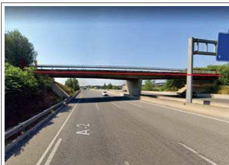
Pas pel pont de l'autopista AP-7 PK 63+615, amb tub metàl·lic
