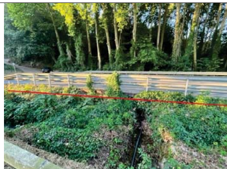
Pas pel pont de sobre el Torrent de Ca l'Aulineta, amb tub metàl·lic, a la carretera N-141e PK 104+990
