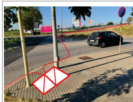
Micro-rasa tipologia ST-1, a la girola del centre comercial Espai Gironès i el C/ Lingen, amb pericó a vorera tipus C2 (17155PE2409)
