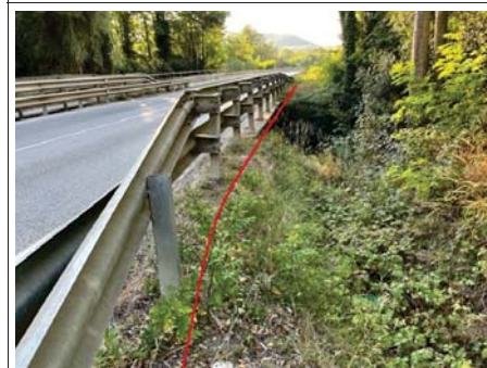
Pas pel pont de sobre la Sèquia de Bescanó, amb tub metàl·lic, a la carretera N-141e PK 106+720
