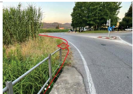
Creuament del Torrent de la Vilaplana amb tub metàl·lic i pericó de sortida tipus A al voral (17020PE2414)
