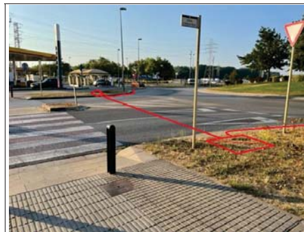
Pericó tipus B2, a vorera (17155PE2414) i sortida de la girola per l'Av de la pau amb tipologia ST-8 a rigola
