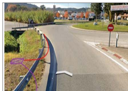
tram existent finalitzat a la girola d'entrada a Bescanó, a la carretera N-141e PK110+535, C/ Major (N-141e) (17020PE2411). Segueix amb ST-8
