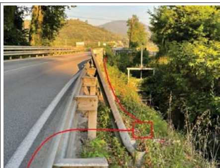
Pericó tipus A, a terres (17020PE2431) a l'entrada del pont del Torrent de Ca l'Aulineta a la carretera N-141e PK 105+000
