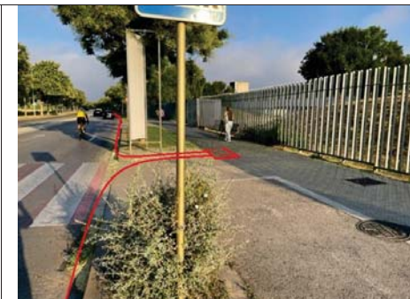
Tram Micro-rasa tipologia ST-8 per rigola, Av de la Pau i pericó a vorera tipus C2 (17155PE2401) a l'entrada del Hospital de Santa Caterina
