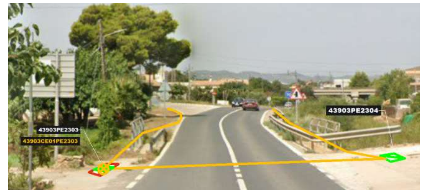
Fig 54: Ubicació caixa d'empalmament 43903CE01PE2303 en pericó 43903PE2303
