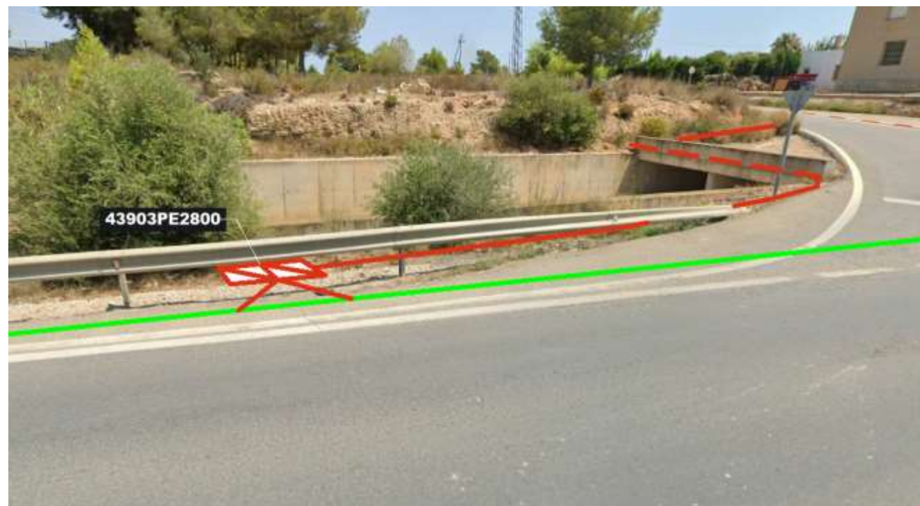
Fig 24: Nou pericó tipus C2 (43903PE2800) interceptant canalització existent, nova canalització rere bionda i tub metàl·lic en pas de riera.
