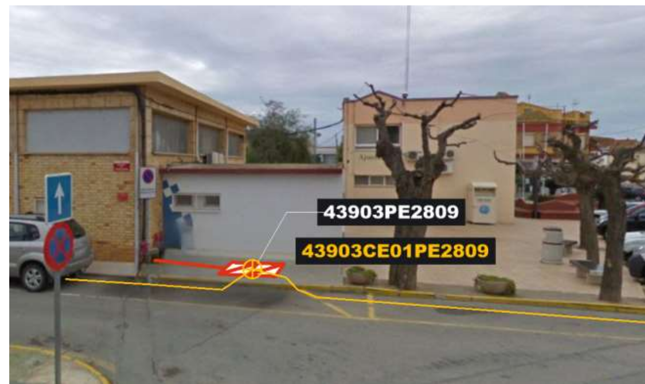
Fig 61: Ubicació caixa d'empalmament 43903CE01PE2809 en pericó 43903PE2809
