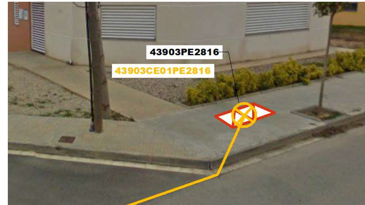
Fig 57: Ubicació caixa d'empalmament 43903CE01PE2816 en pericó 43903PE2816
