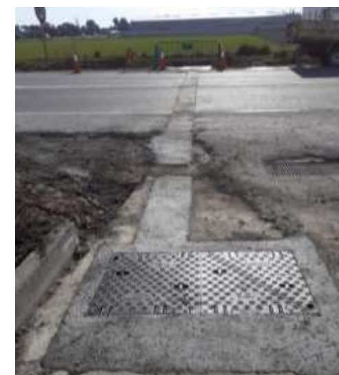
Exemple de encreuament amb ST6 (abans de fresat i asfaltat)
