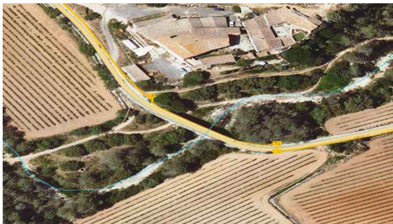
Imatge del creuament del traçat del Carrer del conflent amb la riera de Begues. Font. ACA
