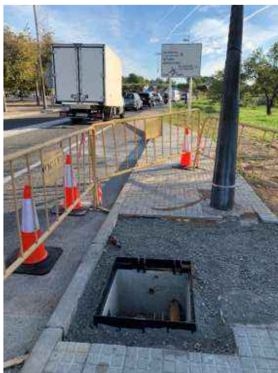
En el tram de Cubelles-Vilanova i la Geltrú l'obra civil comença en la pericó existent 08074PE0011
