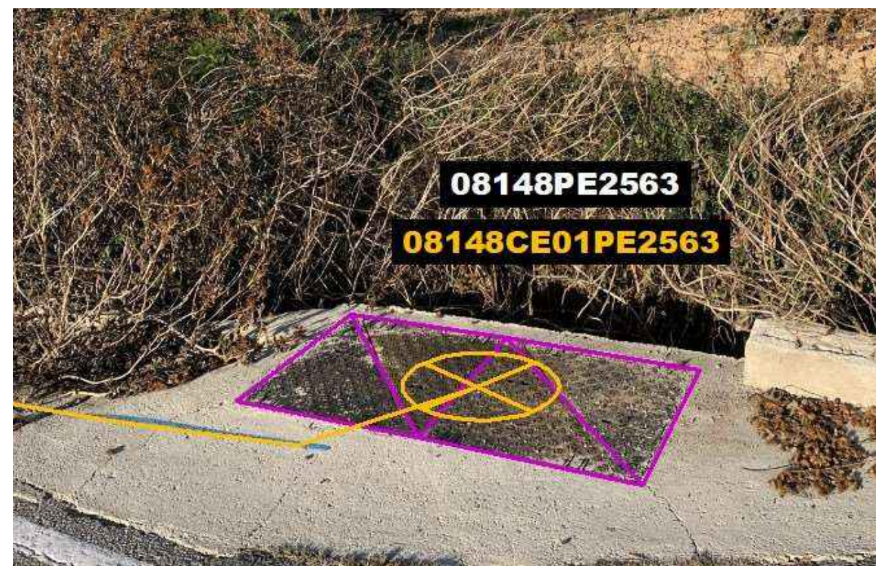
Fig.94: Ubicació caixa d'empalmament 08148CE01PE2563 en pericó existent no inventariada 08148PE2563
