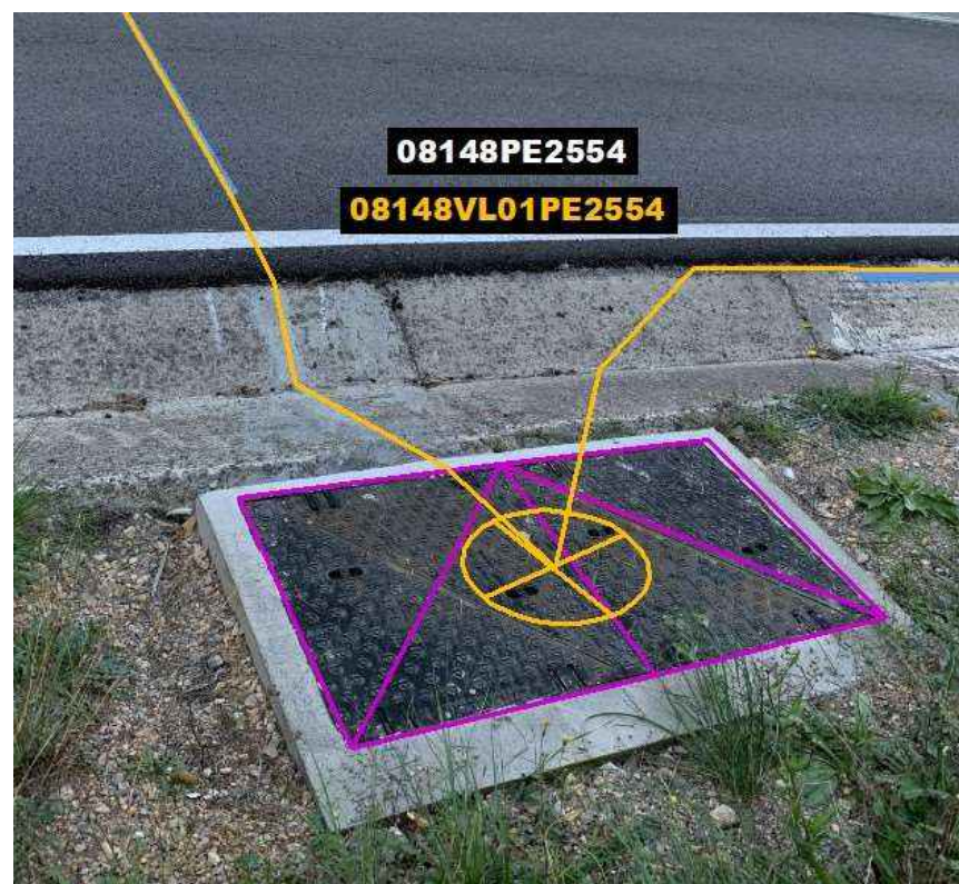
Fig. 96: Ubicació caixa d'empalmament 08148CE01PE2554 en pericó existent no inventariada 08148PE2554
