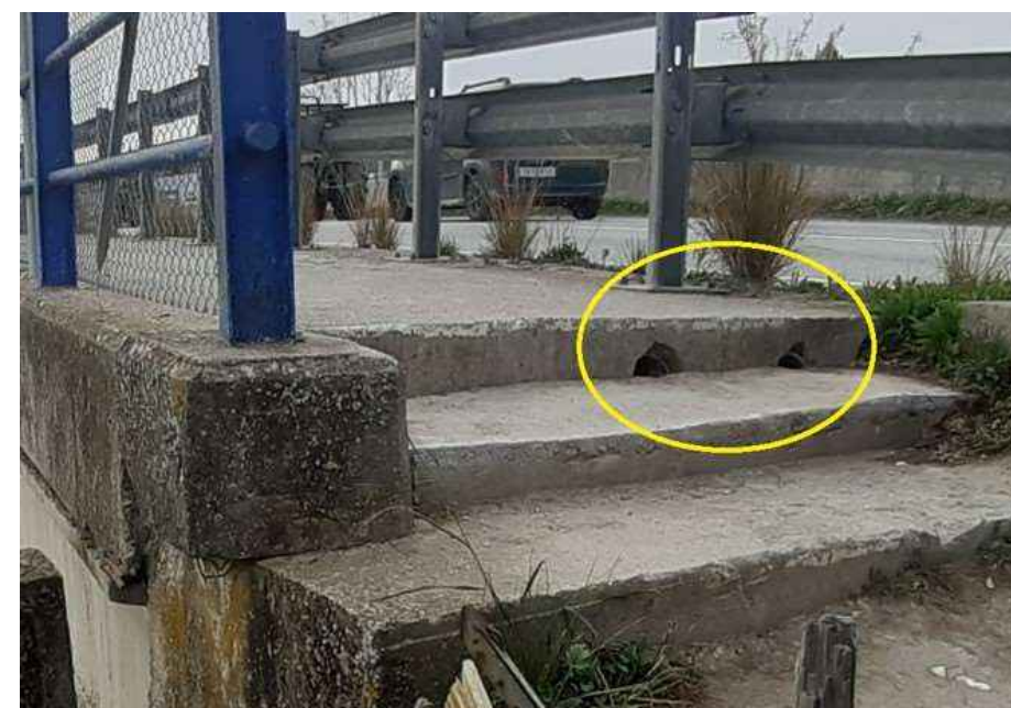
En aquesta imatge es mostra la canalització indicada a la foto anterior
