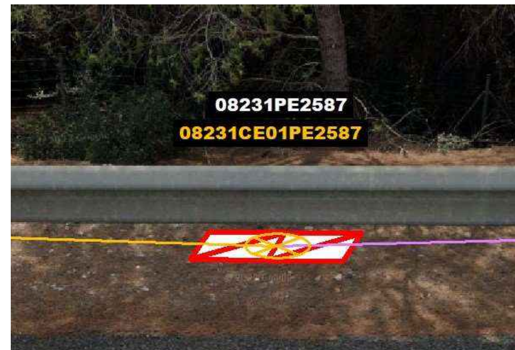
Fig.89: Ubicació caixa d'empalmament 08231CE01PE2587 en pericó 08231PE2587
