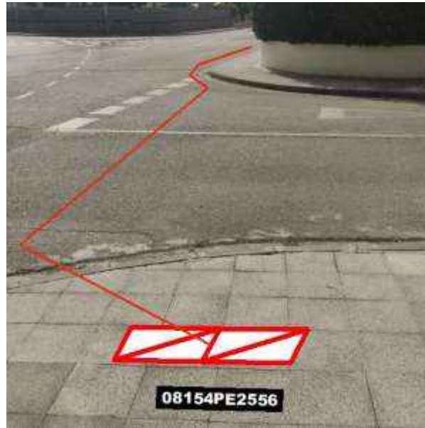
Exemple de reposició i col·locació de pericó
