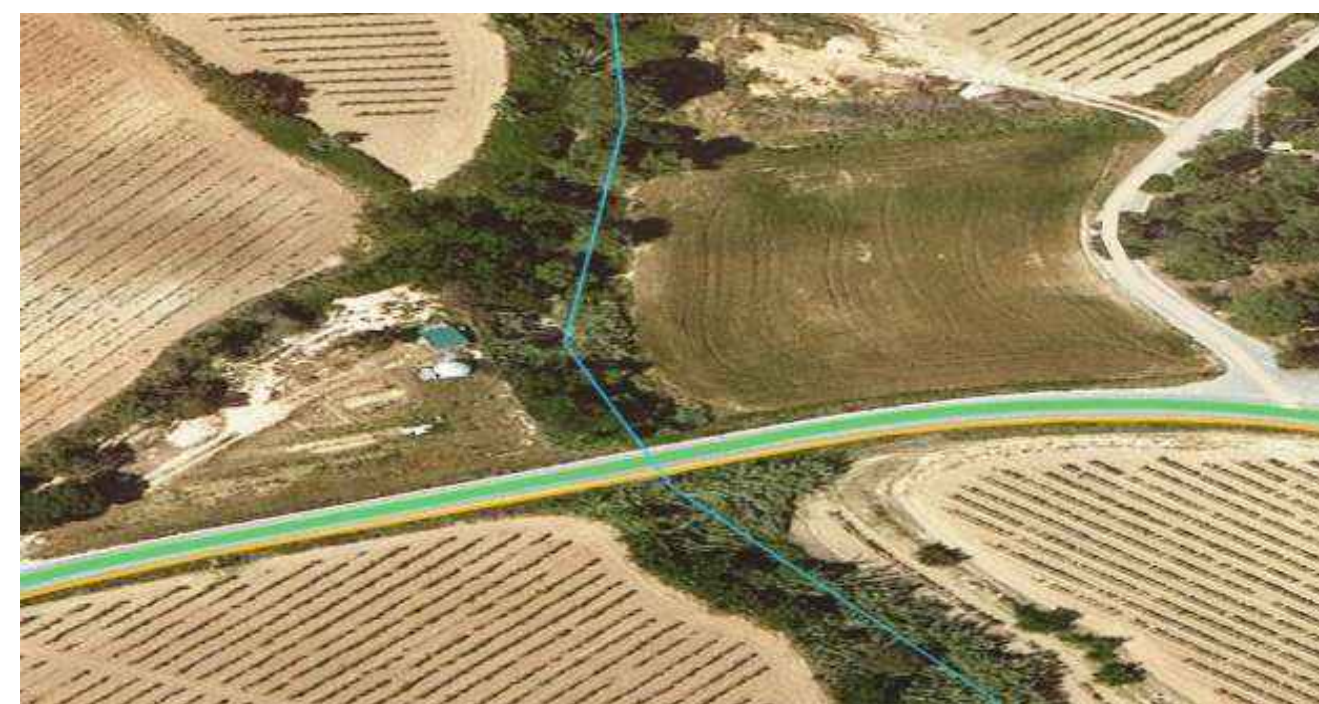
Imatge del creuament del traçat del Carrer del conflent amb el torrent de Cal Biel. Font. ACA
