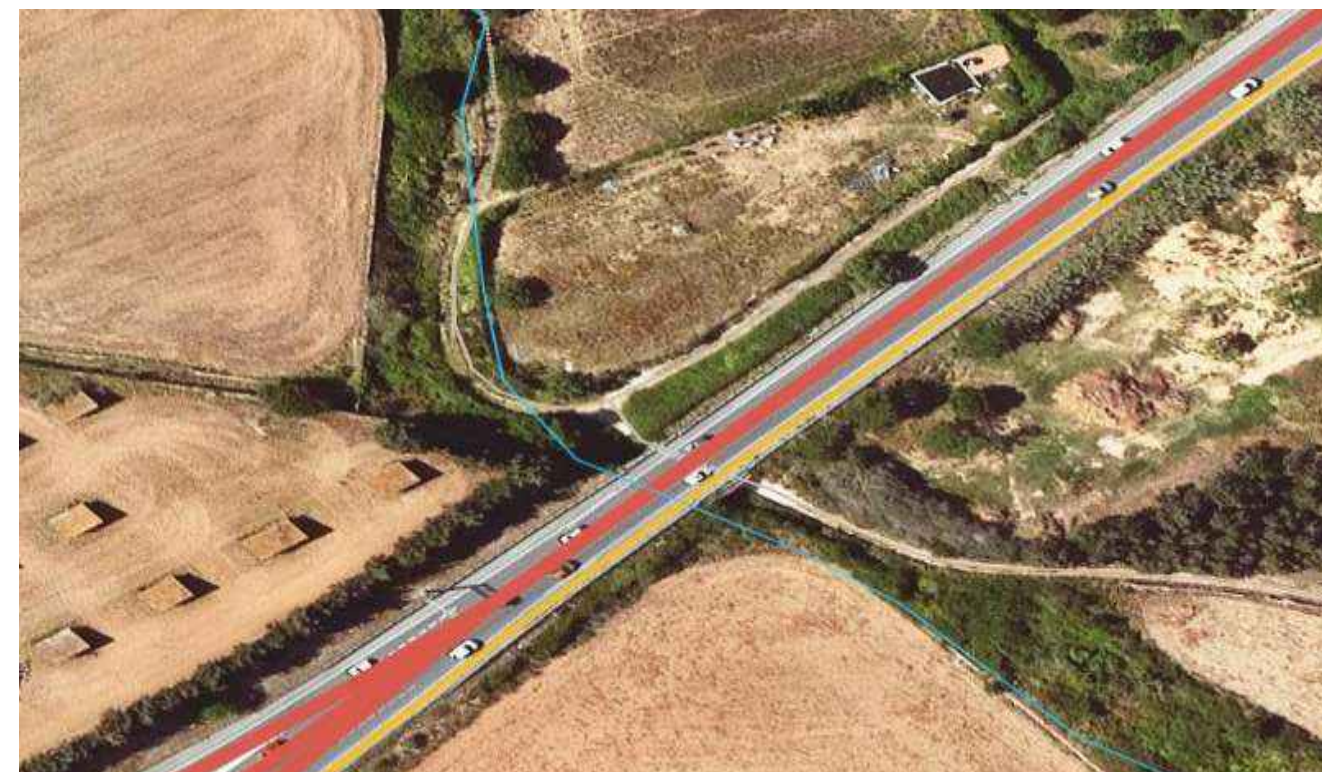
Imatge del creuament del traçat del Carrer del conflent amb el torrent de Sant Joan. Font. ACA
