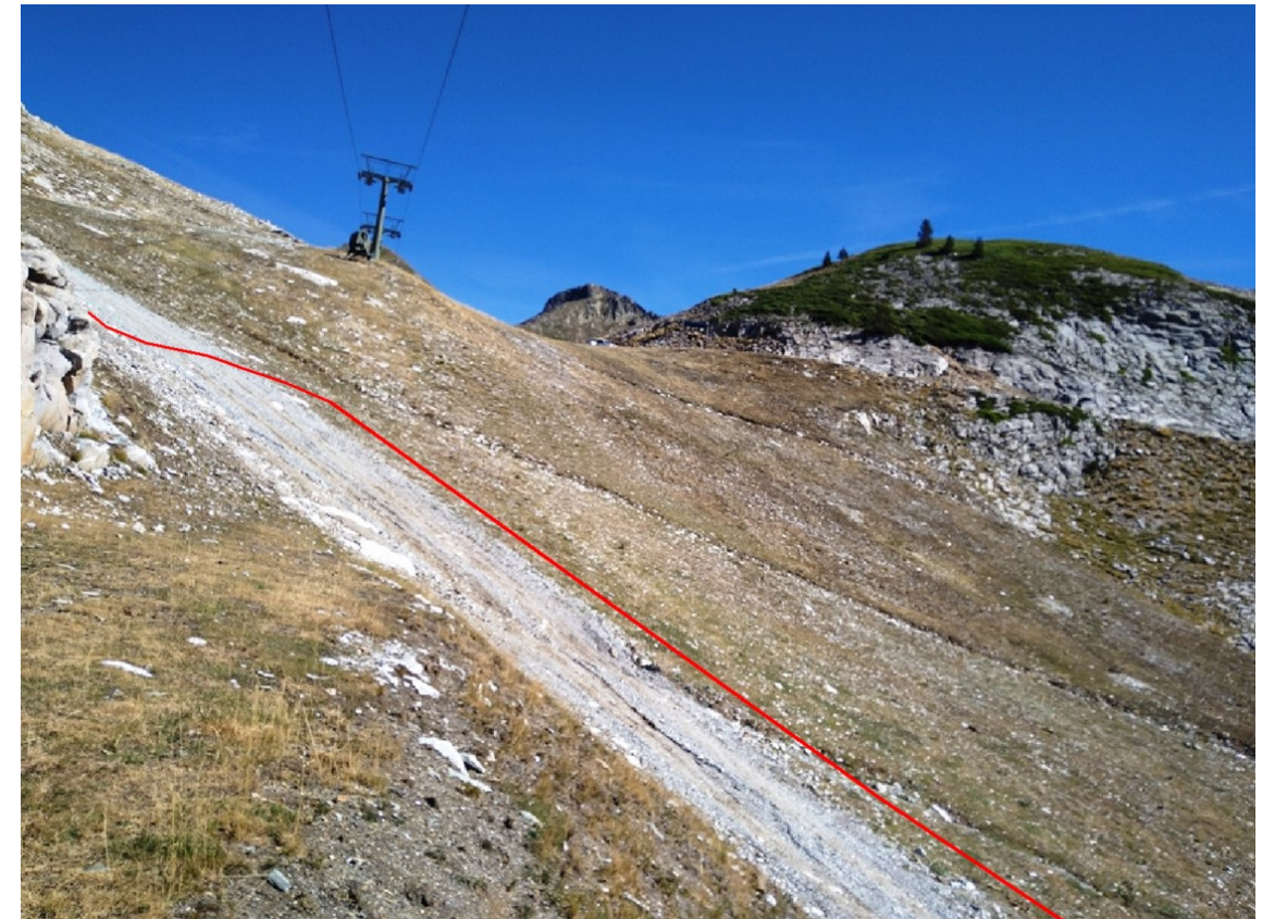
Fig 1.2.4.2.8. Tram obra civil entre 25024PE2013 i 25024PE2014. Detall creuament al costat esquerre.
