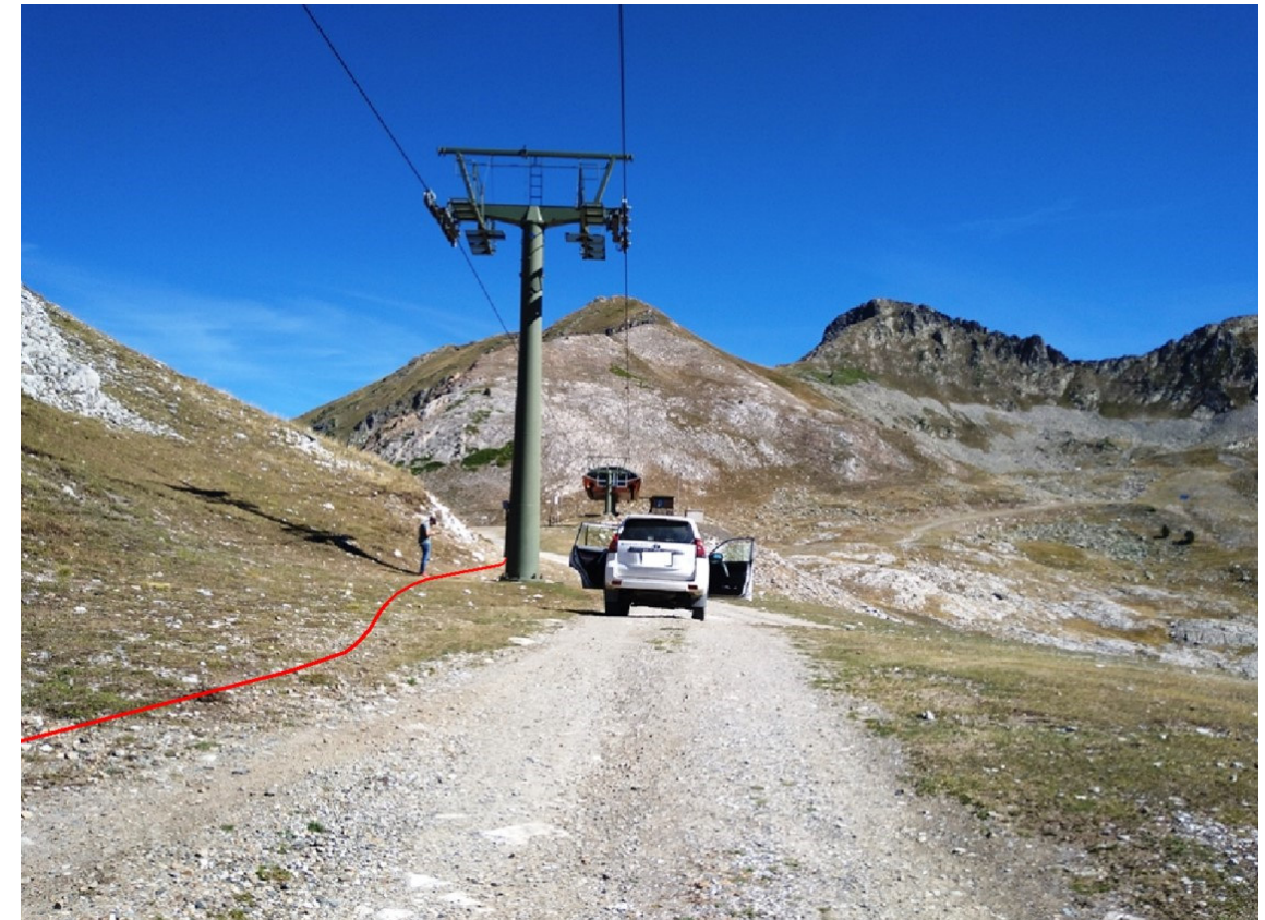
Fig 1.2.4.2.9. Tram obra civil entre 25024PE2013 i 25024PE2014. Detall OC per darrere del telecadires.
