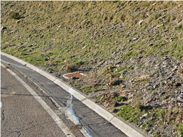
Fig.1.1.1.1.a. Inici de l'obra, pericó existent a la C-28.
