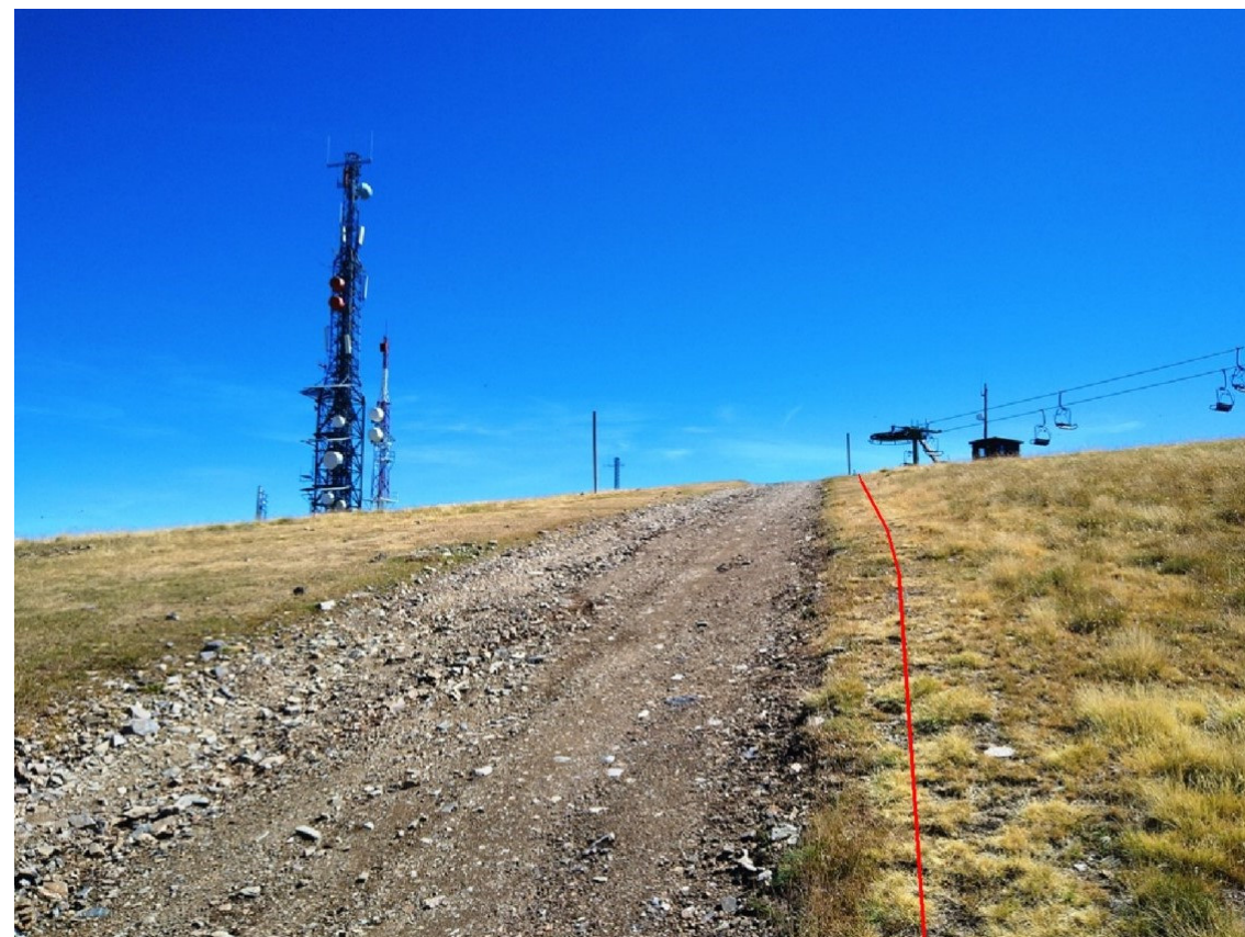
Fig 1.2.4.2.23. Tram obra civil entre 25025PE2030 i 25025PE2031.
