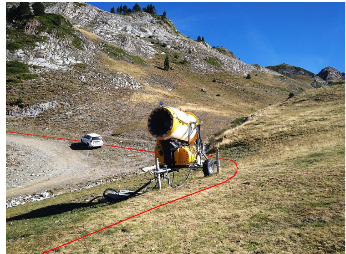
Fig 1.2.4.2.4. Tram obra civil entre 25024PE2010 i 25024PE2011. Detall canonada de neu i pericó existent.
