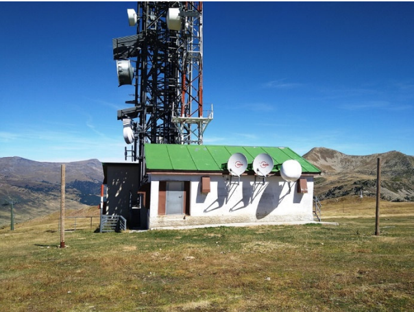
Fig.1.1.1.1.b. Torre de telecomunicacions Cap de Vaquèira.
