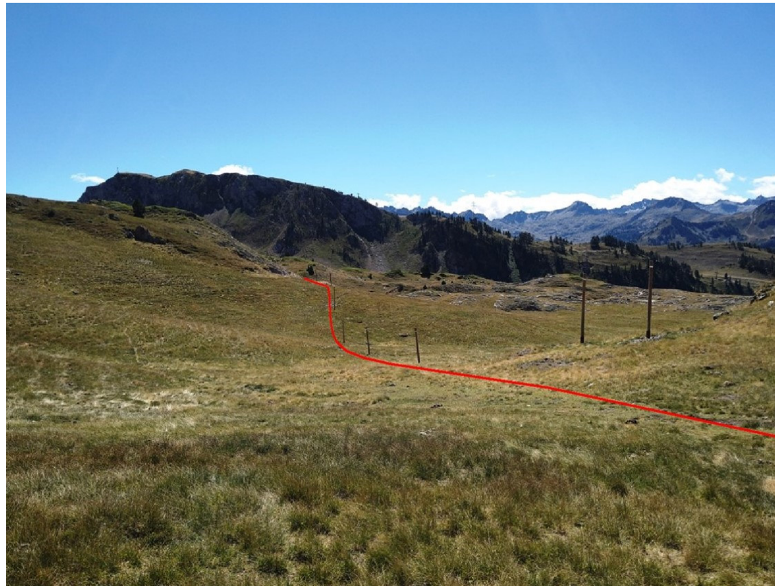
Fig 1.2.4.2.18. Tram obra civil entre 25025PE2027 i 25025PE2028. Detall OC.
