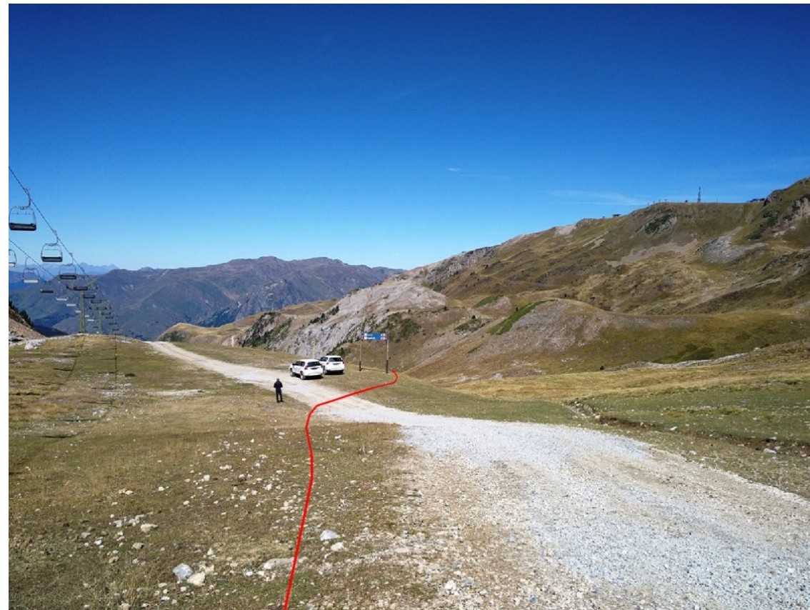
Fig 1.2.4.2.11. Tram obra civil entre 25024PE2014 i 25025PE2025. Detall creuament al costat dret.
