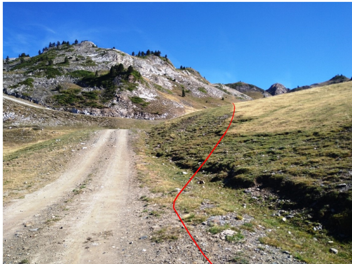
Fig 1.2.4.2.3. Tram obra civil entre 25024PE2010 i 25024PE2011.
