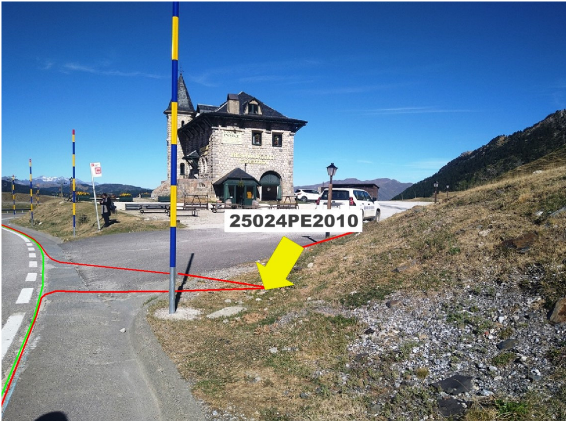
Fig 1.2.4.2.1. Inici de l'obra a la C-28. Ubicació del nou pericó 25024PE2010.
