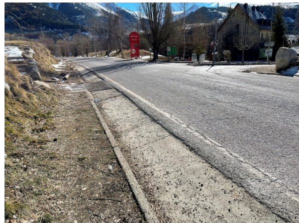
Fig.1.1.1.1.a. Inici de l'obra, pericó projectat 25043PE2362.
