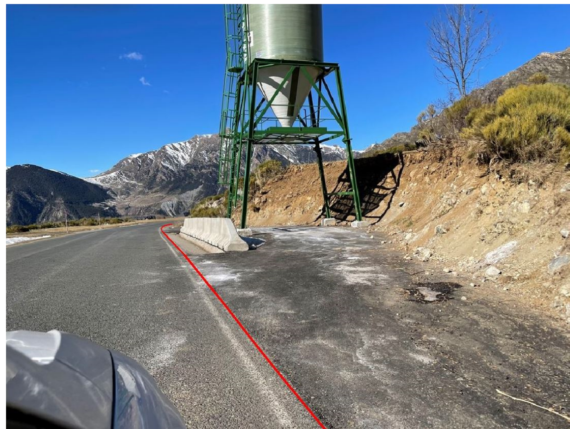
Fig 1.2.4.2.3 Tram d'obra civil entre 25043PE2000 i 25043PE2001.
