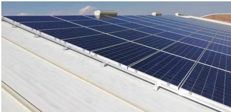
Figures.3. Imatges del suport de Bultmeier tipus coplanar
