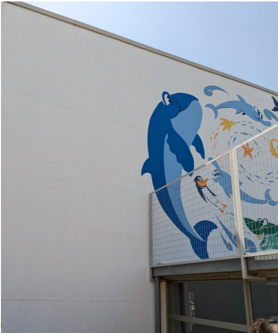
Fotografia 5: Zona instal·lació nova escala de gat protegida d'accés a la coberta
