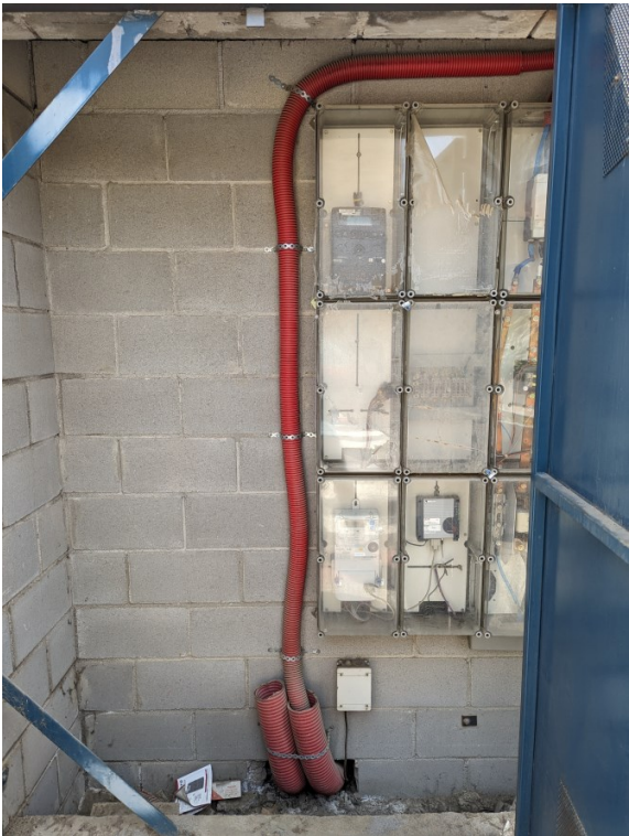
Fotografia 3: Interior armari comptador existent
