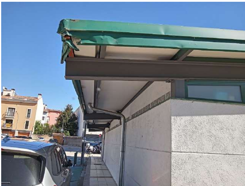
Vista inferior del forjat de coberta, on s'observen els panells sandvitx.
