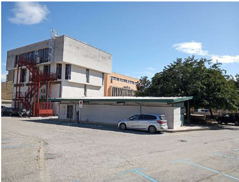
Vista global de la coberta. S'observa la xapa grecada d'acabat i l'estructura metàl·lica del conjunt.
