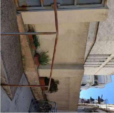
Part interior mur perimetral on s'ubicarà el punt de connexió
