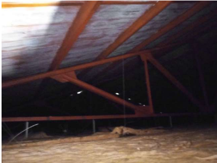
Vista dels cavalls metàl·lics triangulats de coberta.
