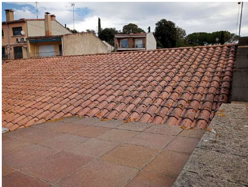
Superfície de la coberta on s'han de instal·lar els panells fotovoltaics.
