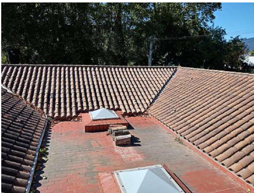
Vista de la coberta de l'ampliació posterior de l'edifici.
