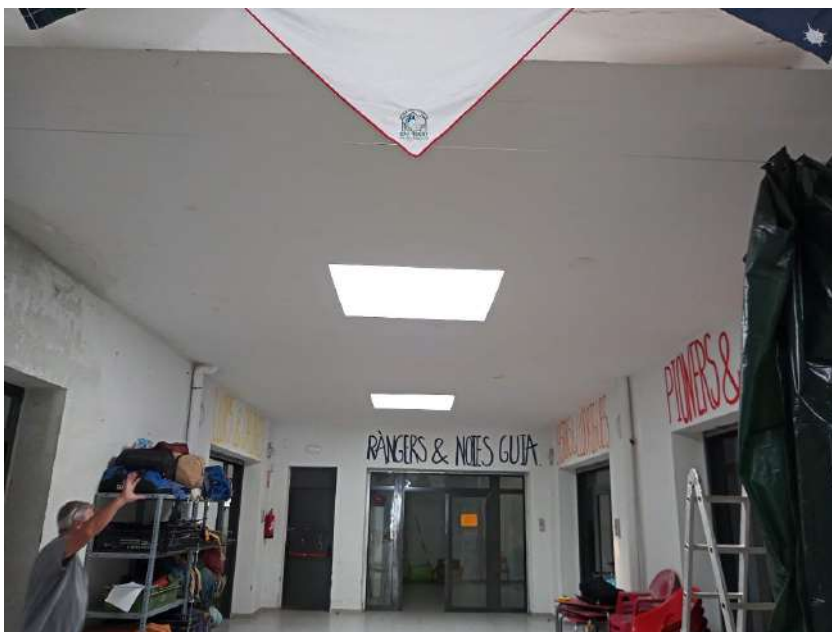
Vista inferior del forjat de l'ampliació de l'edifici, en la que s'han de instal·lar els panells fotovoltaics.
