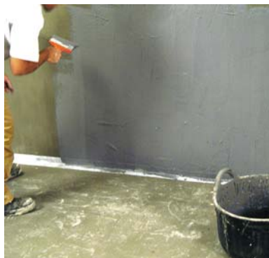
Aplicación de la 1ª mano de HIDROFIX .
