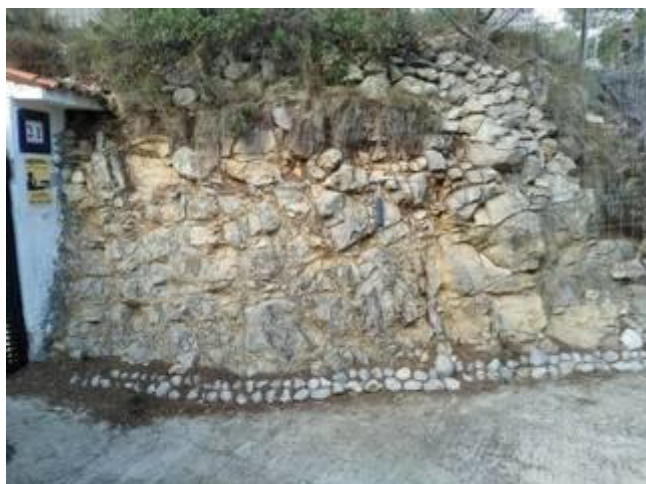
Vista general dels materials rocosos aflorants utilitzats per la valoració RMR
