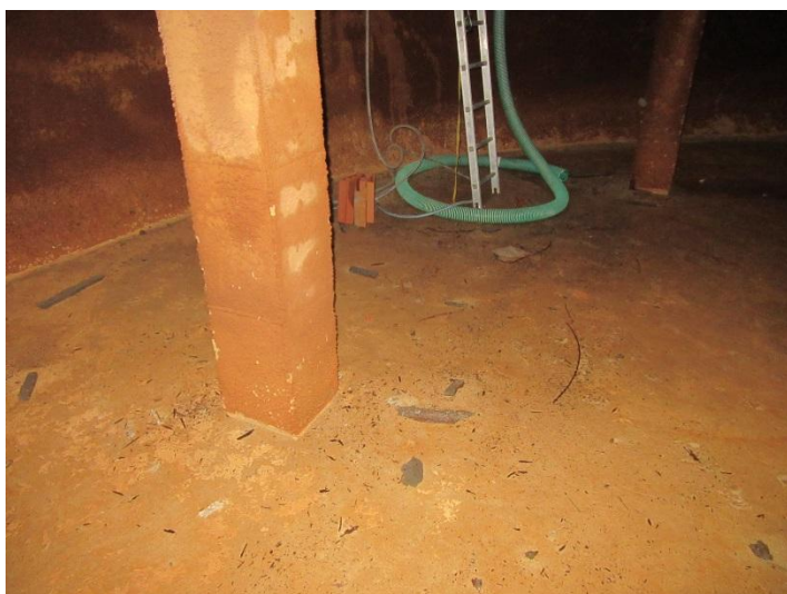
Foto 15: Interior del dipòsit, terra
