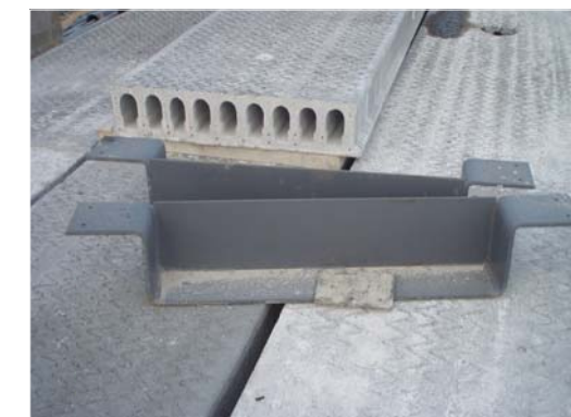
2 - DETALL PEÇA ESPECIAL PER LA PLACA ALVEOLAR
