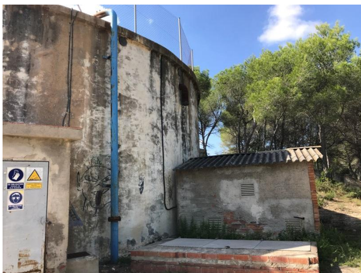
Foto 3: Casetes de cloració i control
