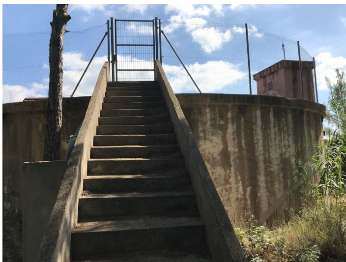
Foto 4: Escala d'accés a la coberta
