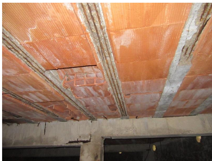
Foto 14: Interior del dipòsit, sostre
