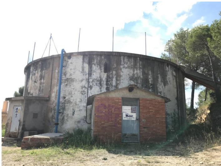
Foto 1: Dipòsit, caseta i escales d'accés a coberta del dipòsit
