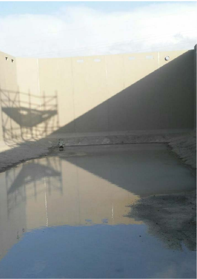
IMATGE SOLERA DEL DIPÒSIT AMB PENDENT PER DESAIGUAR
