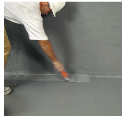
Aplicación de la 2ª mano de HIDROFIX .
