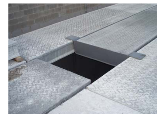
3 - COL·LOCACIÓ FINAL DE LA PEÇA PER BOCA HOME
