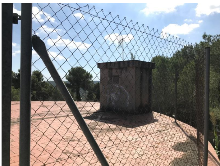
Foto 5: Coberta del dipòsit
