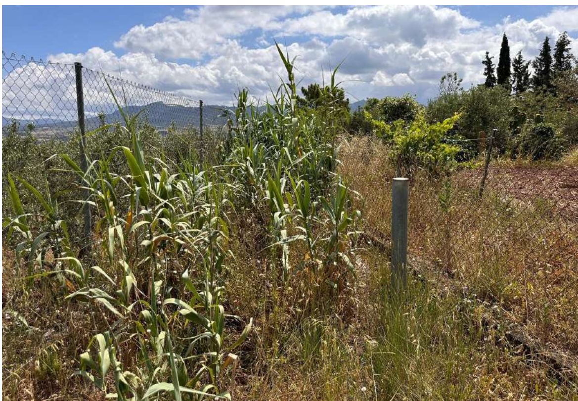
Fotografia 4. Tram d'antiga séquia amb registre de pas de canonada existent
