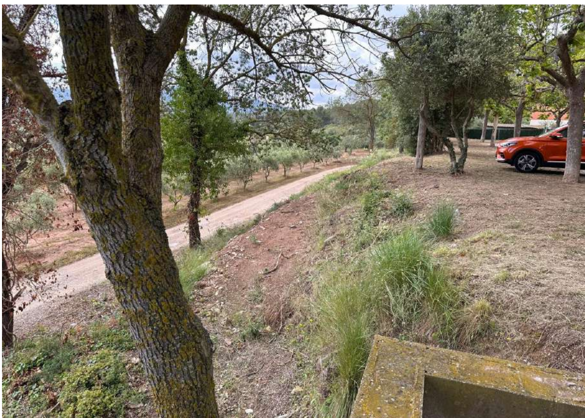
Fotografia 10. Tram d'antiga séquia. Zona de nou mur de formigó prefabricat i canvi a camí
