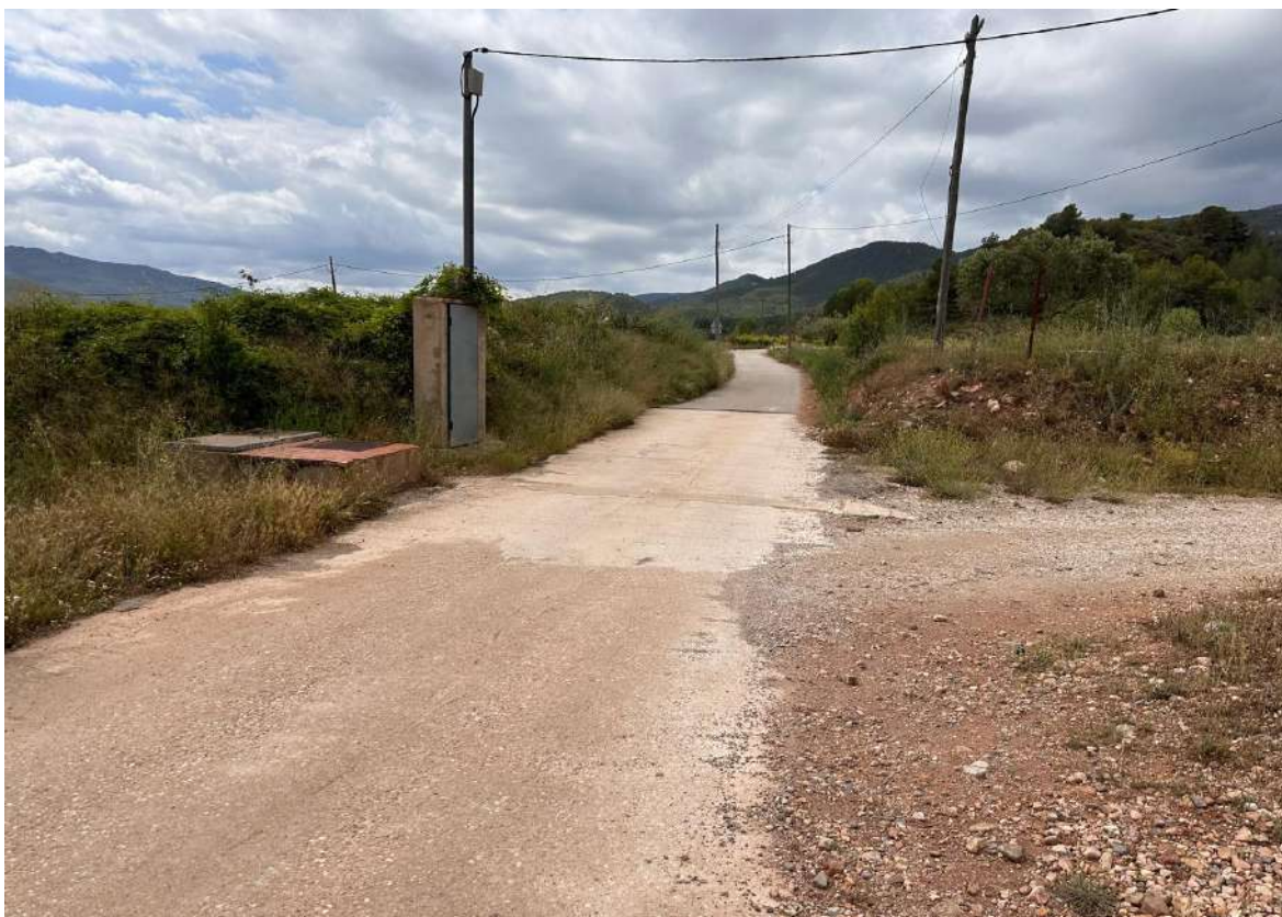
Fotografia 16. Tram per camí de l'Ermite St. Josep fins a pericó de registre i connexió a Barranc de La Pasquala
