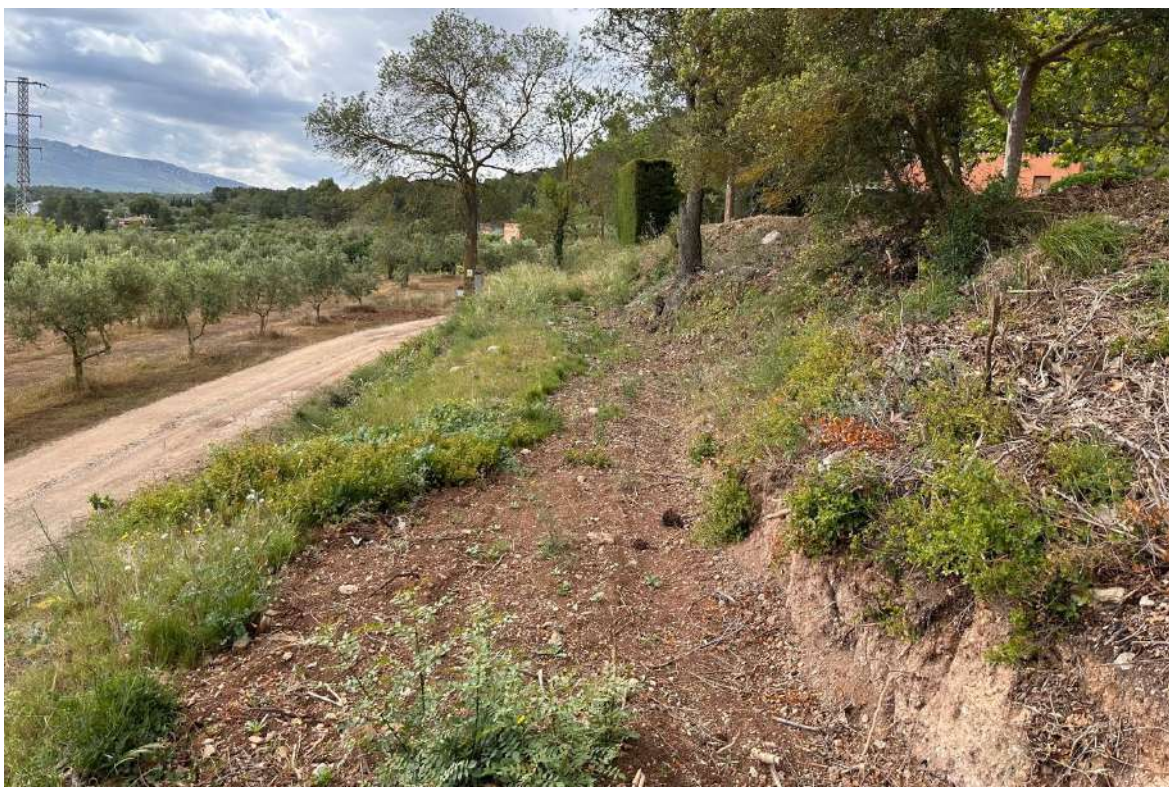
Fotografia 9. Tram d'antiga séquia. Zona de nou mur de formigó prefabricat
