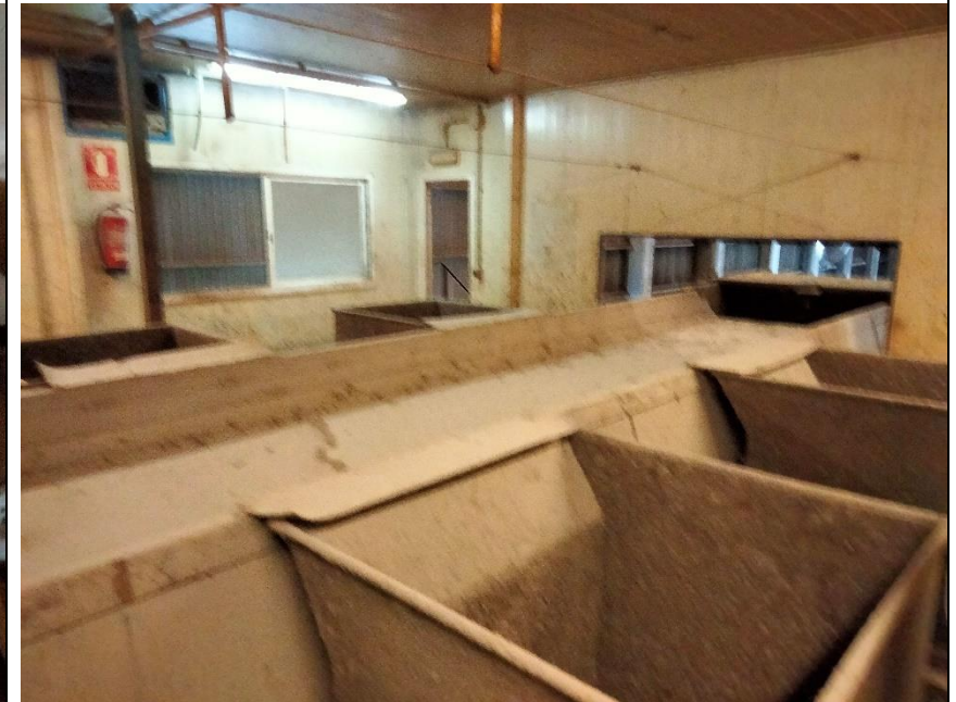
20.- Interior cabina triatge primària línia 2
