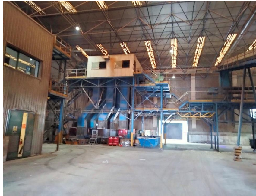
8.- Cabina i obrebosses de la línia 2.
