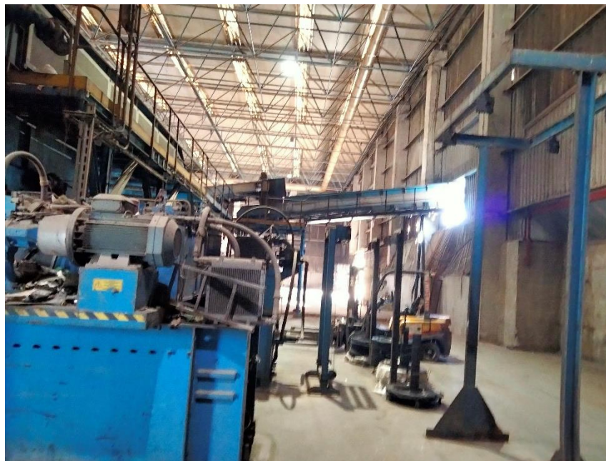
16.- Sortida línia rebuig línia 1
