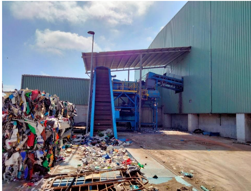
18.-Compactador a desmuntar
