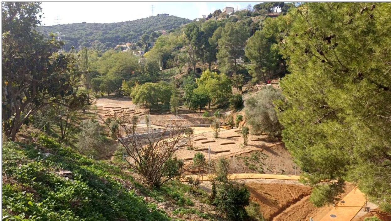
06. Fotografia executió de la Fase 1. (font. BTV)
