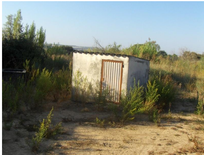
Caseta de les vàlvules
