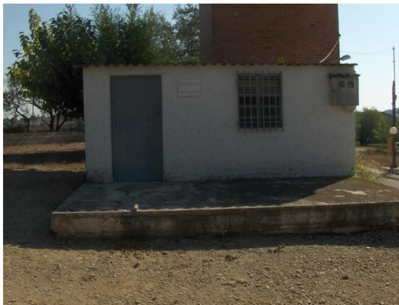
Dipòsit soterrat i caseta de potabilització de la Urbanització Sant Miquel
