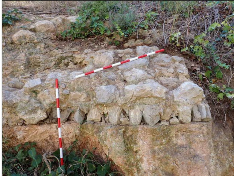
Figura 7 | Vista frontal del tram 2. S'observa clarament la filada de pedres verticals a la base de l'estructura.
