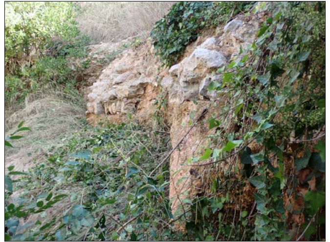
Foto 8. Tram 1 (al fons) i tram 2 (en primer terme) afectats pel rebaix que generà el corredor.
