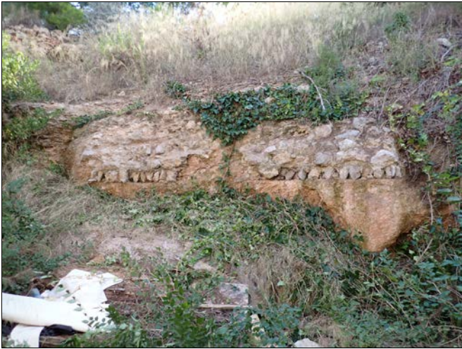
Foto 7. Tram 1 i tram 2 de les restes de la conducció presents en el perfil nord-oriental.
