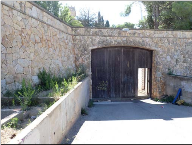
Foto 1. Entrada al recinte de l'auditori del Camp de Mart des de l'avinguda de la Reina Maria Cristina.
