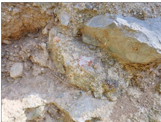
Foto 17. Detall de la fàbrica de maçoneria de la part superior del tram 2.
