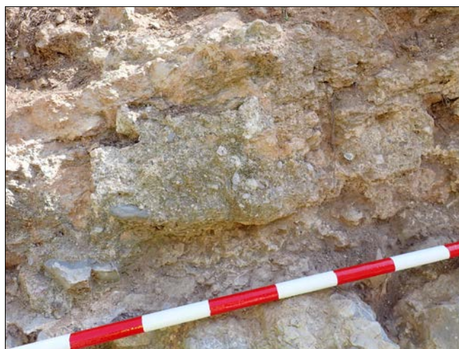
Foto 18. Capa de morter de calç adherida al front rocós (tram 2).
