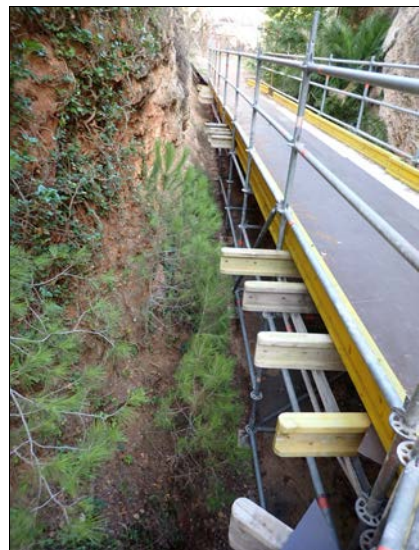
Foto 6. Fons de la gran trinxera i passarel·la temporal.
