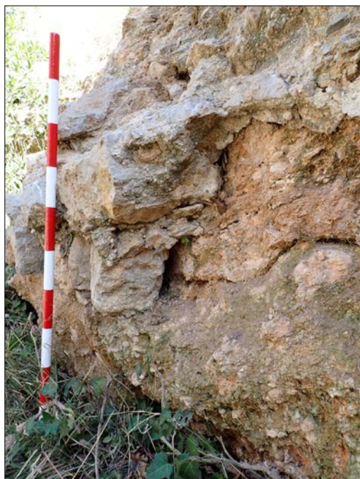
Figura 5 | Detall de l'extrem sud-oriental del tram 1 on s'observa com la fàbrica de maçoneria (UA 2) es troba adherida al retall UA 1.
