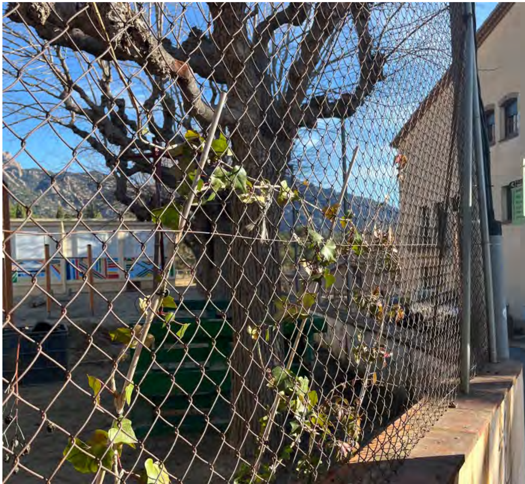
F9. Vista malla sobre murs existents de tancament
