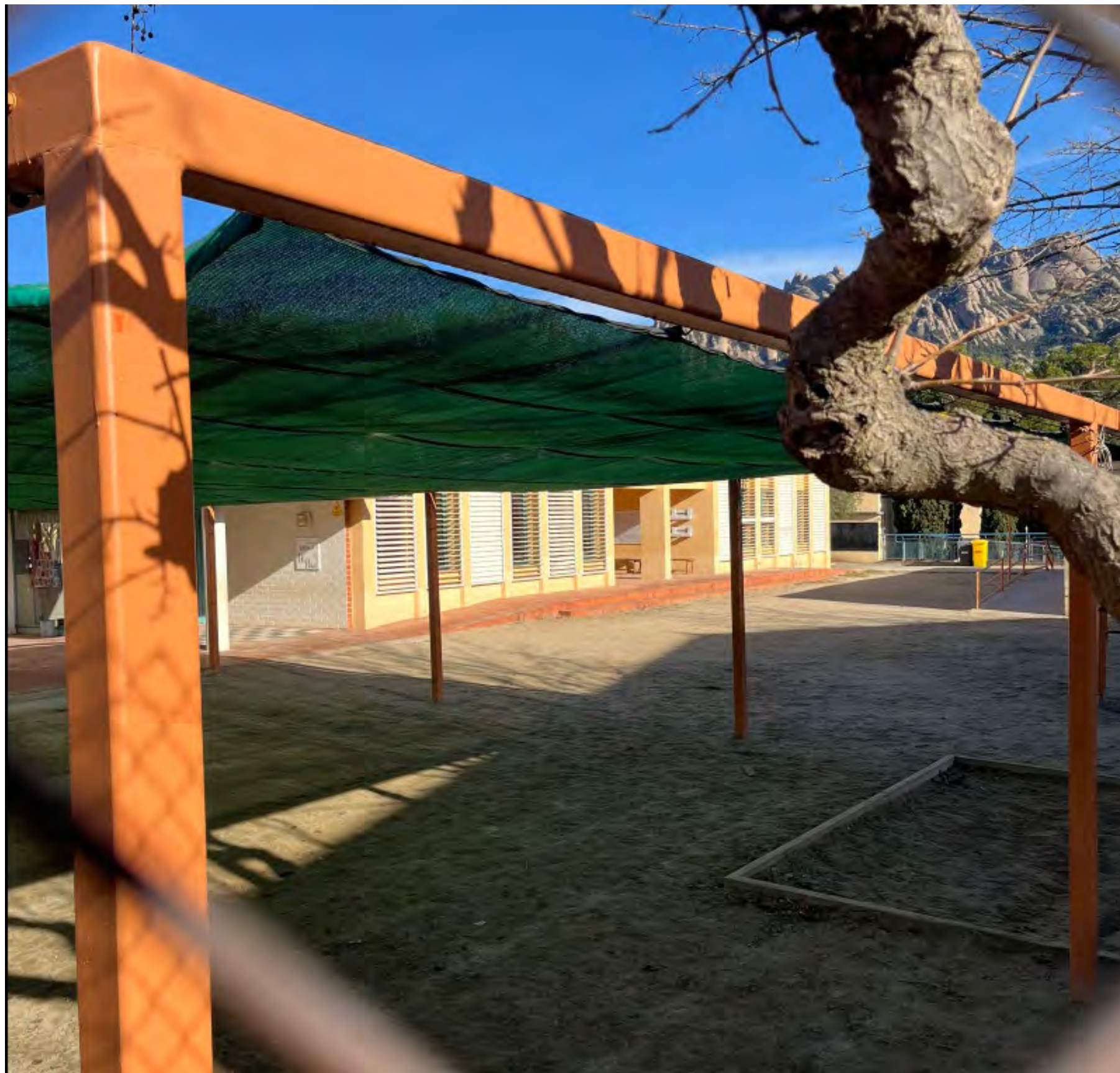
F11. Vista de l'estat actual d'arbres existents i tancament exterior d'escola
