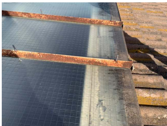
Vidre de 6mm de gruix i perfils de suport
