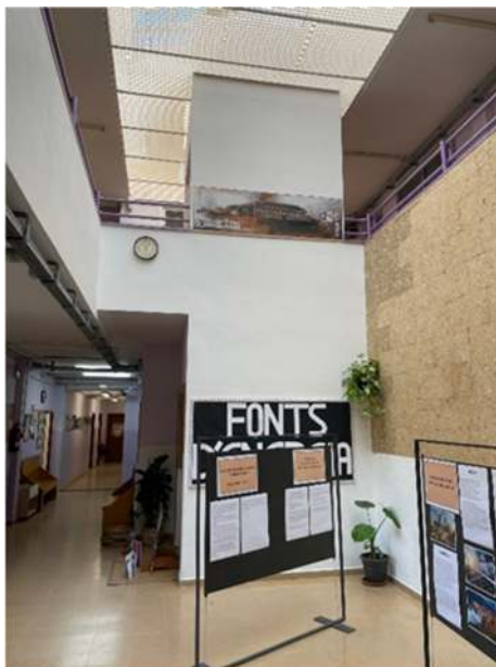
Buc existent per instal·lació de l'ascensor
