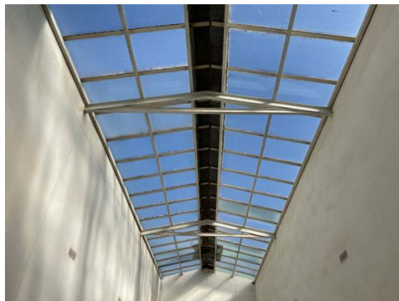
Interior lluernari i estructura de suport
