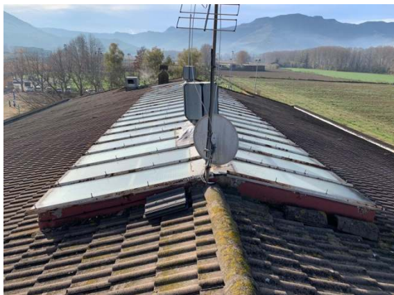
Exterior lluernari coberta
