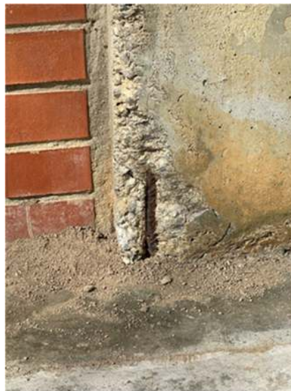
Pilar edifici auxiliar
