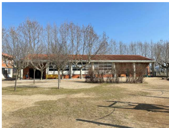
Façana Sud edifici auxiliar
