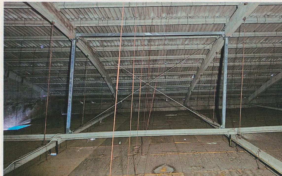
Imatge 4 Marc metàl·lic triangulat en un pla perpendicular a les encavallades. Tirants de suport del fals sostre rovellats
