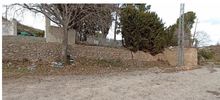
6.- Obertura camí del Pou de Neu cap al pou de Neu (actuació 1-tram1)
