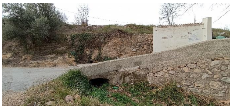
4.- Canalització aigües pluvials
