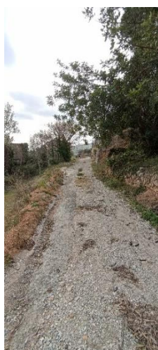
8.- Estat actual camí Pou de Neu (actuació 1-tram1)
