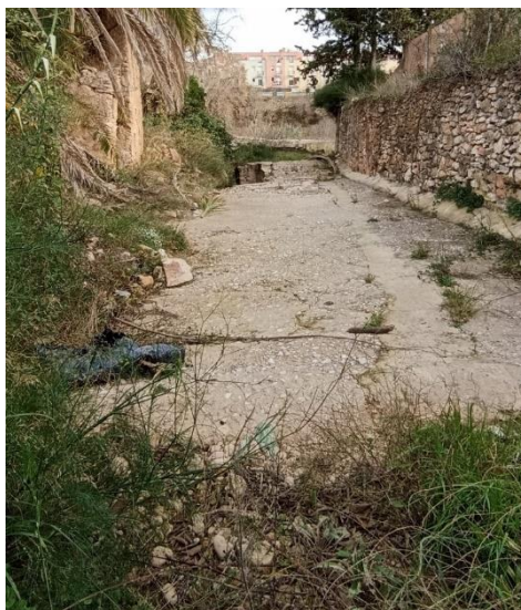
14.- Tram a condicionar: Torre d'en Bernat (actuació 2)
