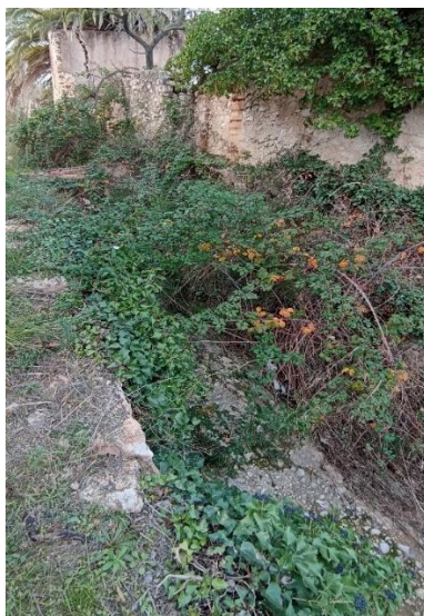
15.- Tram a condicionar: Torre d'en Bernat (actuació 2)
