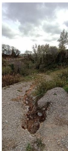
9.- Estat actual baixada al Pou de Neu (actuació 1-tram 1)
