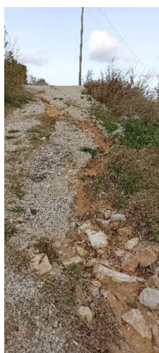
10.- Estat actual pujada ruta circular via verda (actuació 1-tram 1)
