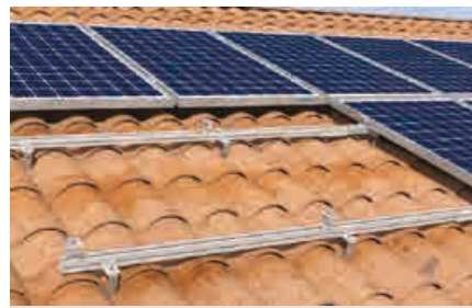
Detalle: Posicionamiento de las abrazaderas
