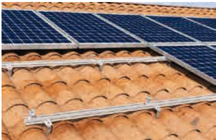
Cubierta coplanar con teja
