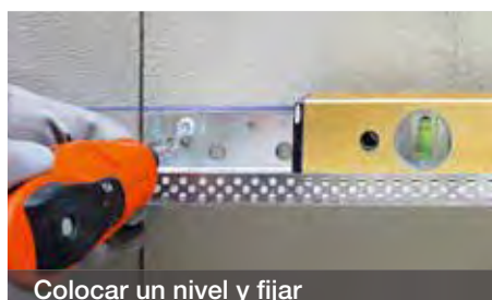
Realizar primer anclaje
