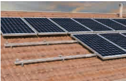
Cubierta coplanar con teja
