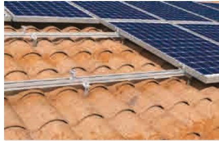
Detalle: Posicionamiento de las abrazaderas
