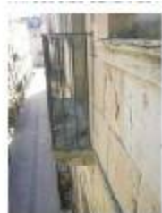
① Descrostant parcial de les pedres de la façana Consolidació per injecció de morter de calç i claus de lligat d'acer inoxidable
