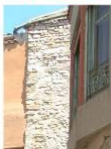
⑧ Descrostament parcial de l'arrebossat estucat de morter de calç deixant la pedra a la vista Sanejament de l'arrebossat i tornar a realitzar l'estucat a la calç
