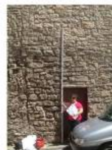
④ Fisura vertical a la pedra Sanejament de la pedra arenisca i rejuntat de les fisures i la pedra
