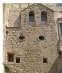
⑤ Despeig de la pedra i fusts verticals estructurals Consolidació per injectat de morter de calç i claus de fegat d'acer inoxidable Rehabilitació conservativa amb morter de calç i sòms de pedra arenisca afunada Substitució parcial per encols de nova pedra
