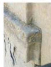
⑤ Humitats Substitució parcial per encaix de nova pedra
