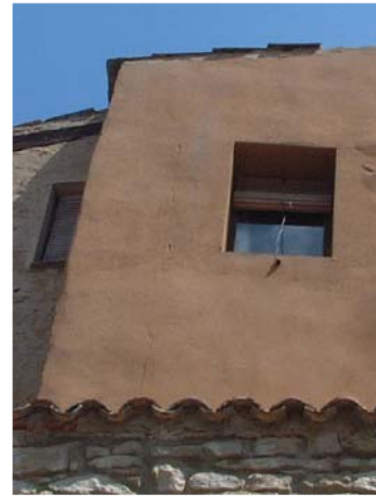
② Fissura vertical de l'arrebossat estucat de morter de calç Rejuntat de fissura i sanejament de l'arrebossat i tornar a realitzar l'estucat a la calç
