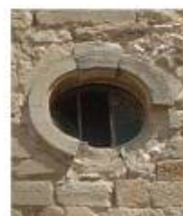
⑥ Despeig i descobriments de la pedra Substitució parcial per encols de nova pedra
