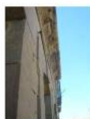
⑧ Desgast i descrostant comissas Restitució concavitats amb morter de calç i soma de pedra arenisca triturada
