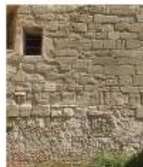
③ Descobriments parcial de l'arrebossat estucat de morter de calç deixant la pedra a la vista Sanejament de l'arrebossat i tornar a realitzar l'estucat a la calç
