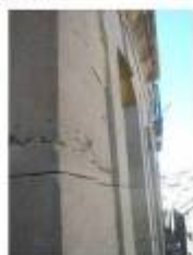
② Fissures horitzontals a la pedra Consolidació per injecció de morter de calç i claus de lligat d'acer inoxidable
