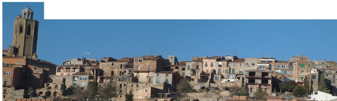
CONJUNT FAÇANA URBANA EST GENERADA PER LA SUCCESSIÓ DE MURS MITGERS DEFINIDORS DE LA PARCEL·LACIÓ GENERADORA DEL CONJUNT URBÀ
