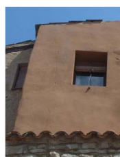
② Fissura vertical de l'arrebossat estucat de morter de calç Rejuntat de fissura i sanejament de l'arrebossat i tornar a realitzar l'estucat a la calç
