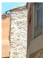
⑧ Descrostant parcial de l'arrebossat estucat de morter de calç deixant la pedra a la vista Sanejament de l'arrebossat i tornar a realitzar l'estucat a la calç
