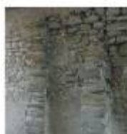
⑦ Descobriments parcial de les pedres de la façana Rehabilitació conservativa amb morter de calç i sòms de pedra arenisca afunada
