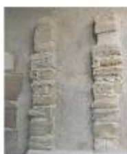
② Descobriments parcial de les pedres de la façana Sanejament de les humitats de la pedra arenisca i rejuntat
