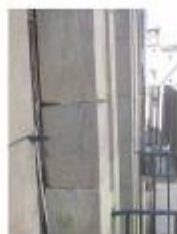
③ Fissures verticals a la pedra Consolidació per injecció de morter de calç i claus de lligat d'acer inoxidable
