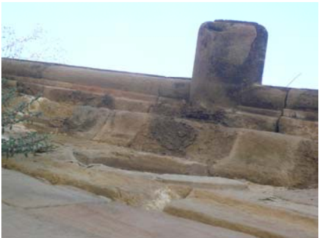
DESCOMPOSICIÓ CORNISA I GÀRGOLA C.MAJOR. INSUFICIENT PROTECCIÓ DE LA FAÇANA DE PEDRA ARENISCA EN DESCOMPOSICIÓ QUE CALDRÀ CONSOLIDAR, FIXAR I ATURAR.
