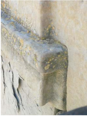
⑤ Humitats Substitució parcial per encaix de nova pedra
