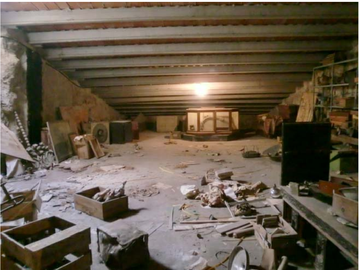
Plana sota coberta orientació sud-est edifici Antiga Biblioteca
