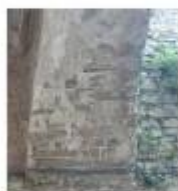
⑦ Descobriments parcial de les pedres de la façana Rehabilitació conservativa amb morter de calç i sòms de pedra arenisca afunada
