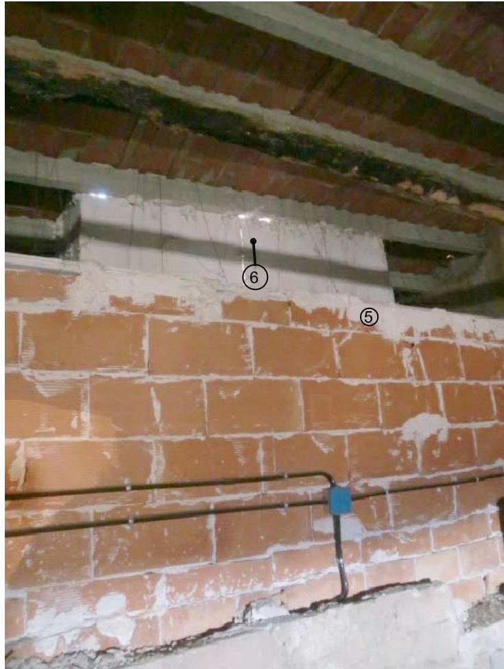
PARAMENT LLUERNARI A PLANTA SOTA COBERTA EDIFICI ESSLÉSIA SANT JOAN DEGOLLAT
