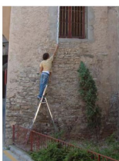
⑤ Descrostant parcial de l'arrebossat estucat de morter de calç deixant la pedra a la vista Sanejament de l'arrebossat i tornar a realitzar l'estucat a la calç
