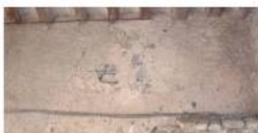
⑧ Humitats i descobriments parcial de l'arrebossat estucat de morter de calç Sanejament de l'arrebossat i les humitats i tornar a realitzar l'estucat a la calç
