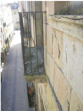
① Descrostament parcial de les pedres de la façana Consolidació per injecció de morter de calç i claus de lligat d'acer inox
