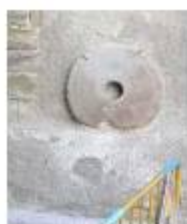
① Descobriments parcial de l'arrebossat estucat de morter de calç deixant la pedra a la vista Sanejament de l'arrebossat i tornar a realitzar l'estucat a la calç
