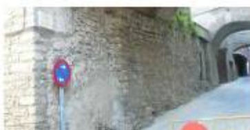
⑨ Descobriments parcial de l'arrebossat estucat de morter de calç deixant la pedra a la vista i despeig de la pedra i fusts verticals estructurals Sanejament de l'arrebossat i tornar a realitzar l'estucat a la calç i reforçat de consolidació de fusta metàl·lica per consolidació estructural
