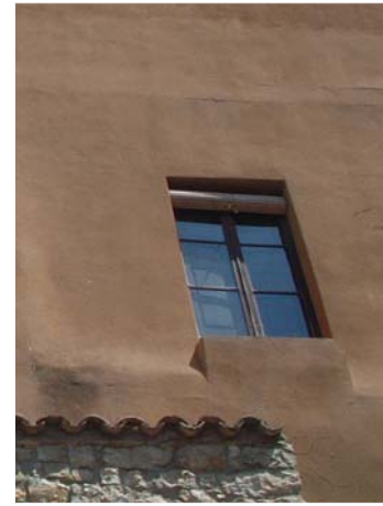
③ Descrostament i Fissures horitzontals estructurals en forjats existents Rejuntat de fissura i sanejament de l'arrebossat i tornar a realitzar l'estucat a la calç
