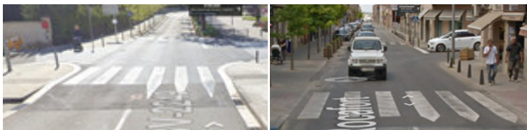
Plataforma reductora de velocitat en cruïlla
