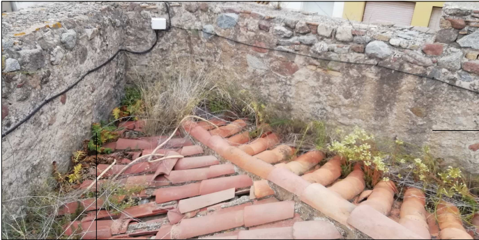
escardejat i arrebossat de coronament i part interior de barana
