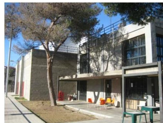
F12 Façana Oest
