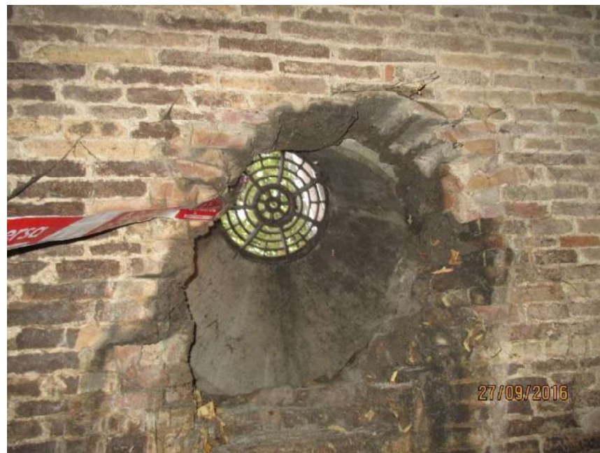
Figura 20.- Vista de les rosques de maons en una connexió de pluvials
