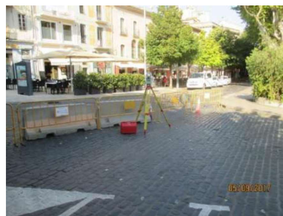
Fotografia 6: Aixecament topogràfic exterior
