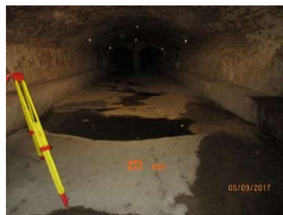
Fotografia 4: Instal·lació de mini prismes per a l'aixecament topogràfic
