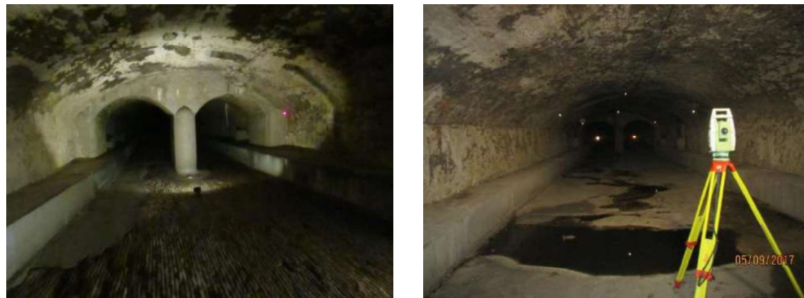
Figura 16.- Aixecament topogràfic de l'interior de la riera, replanteig de punts característics i instal·lació de mini prismes.
