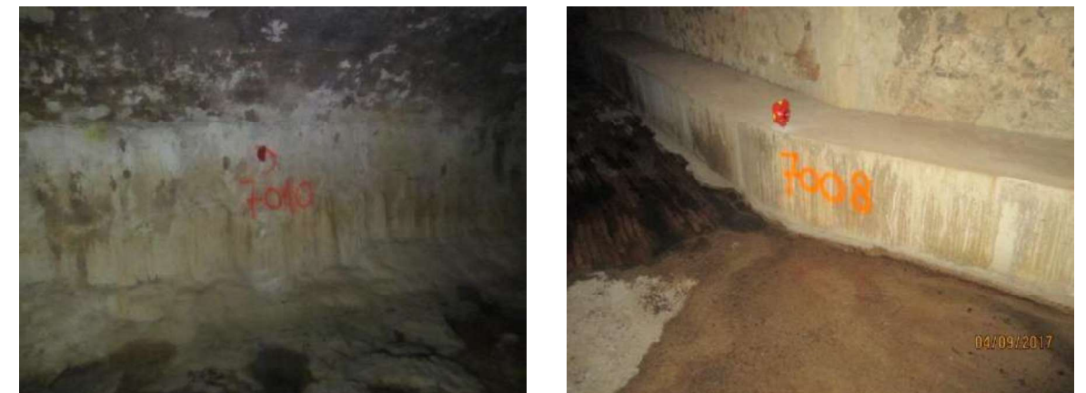
Figura 11. Treballs previs, instal·lació de bases de referència
