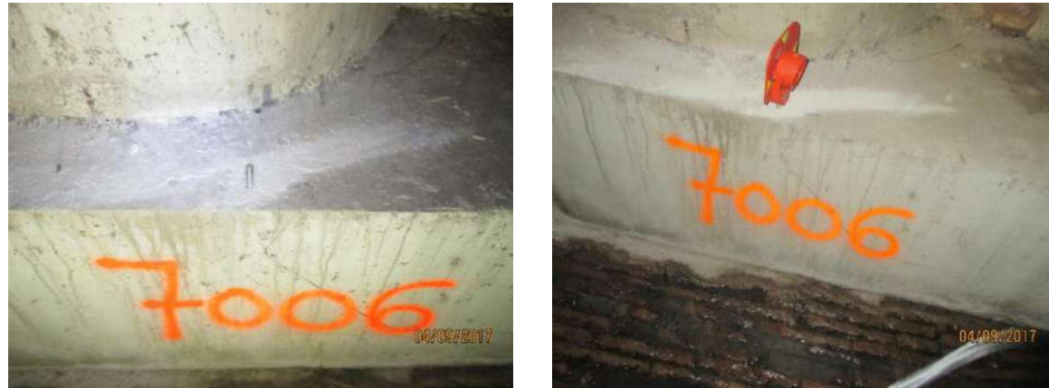
Figura 15.- Instal·lació de bases fixes mitjançant perns de topografia
