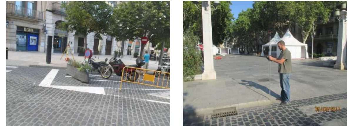
Figura 10. Treballs previs, aixecament topogràfic exteriors.
