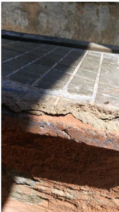
Detall revestiment superfície de rentat.
