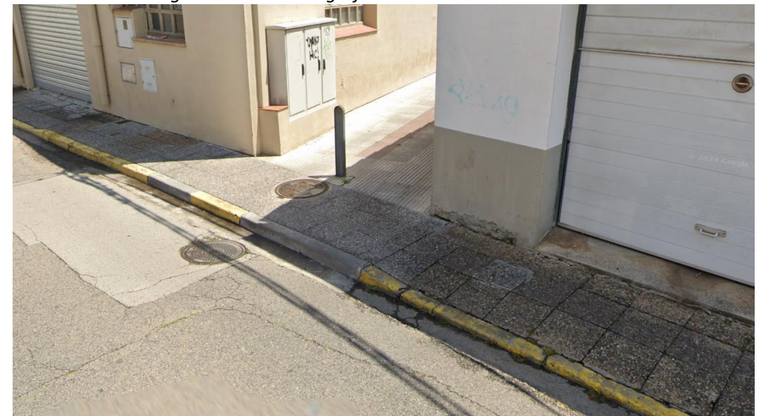
Figura 14. Fotografia estat actual Carrer del Firal, cruïlla amb Placeta de la Font.
