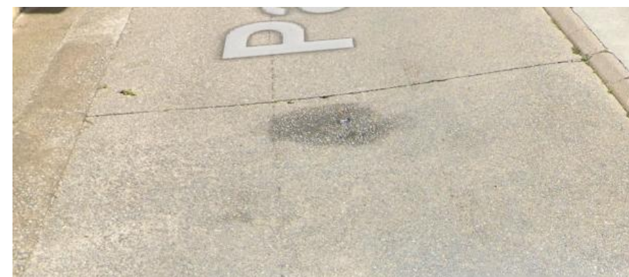
Figura 36. Paviment existent al Passatge de l'Església.
