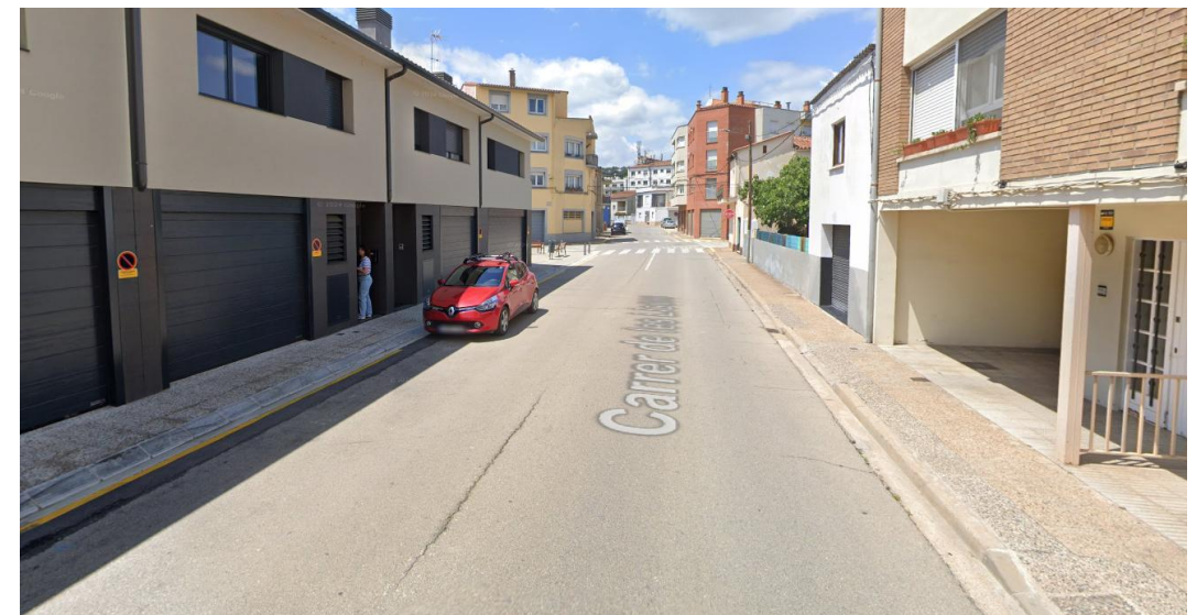
Figura 20. Fotografia estat actual Carrer de les Lloses.
