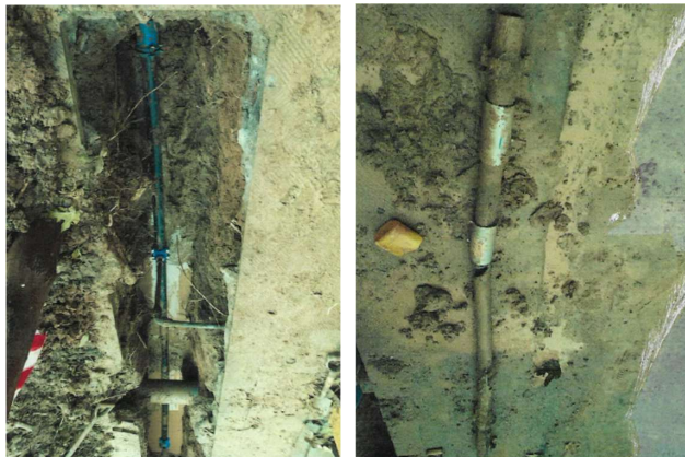
Figura 2. Reparacions fetes al carrer Tarragona
