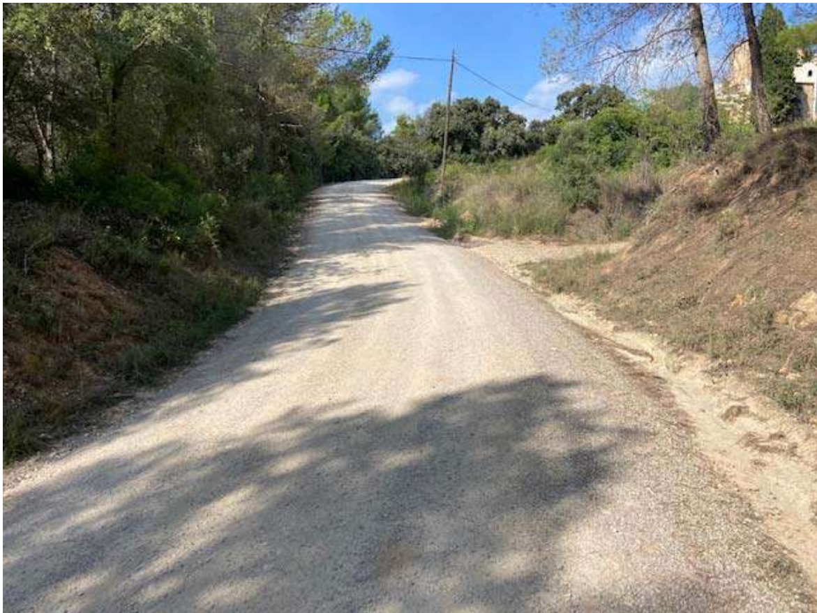
PK 1.020m tram amb pendent des de Torrent a St Vicenç del Morro Curt
