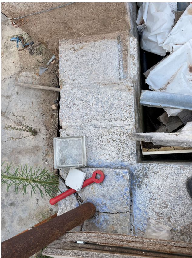
D.F.7 Estructura metàl·lica encastada en mur perimetral de la bassa.
