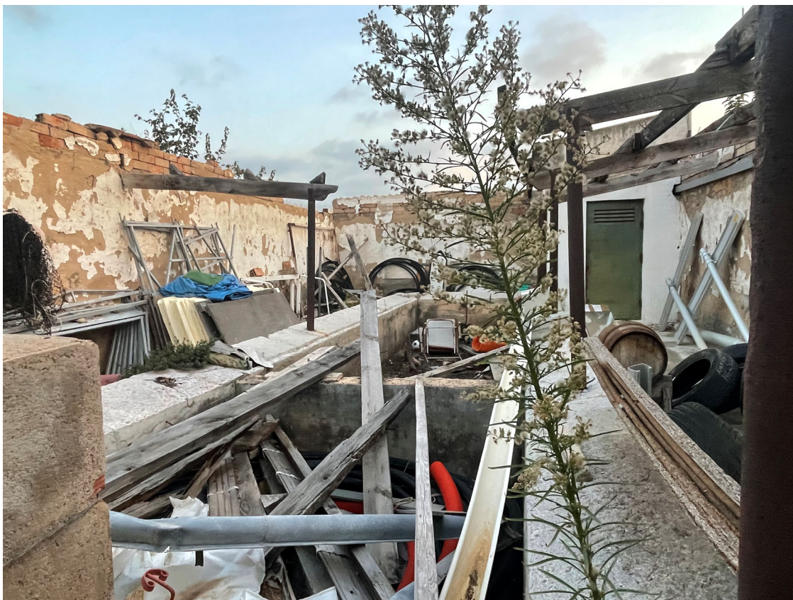
D.F.3 Vista del recinte des de darrera la façana a carrer
