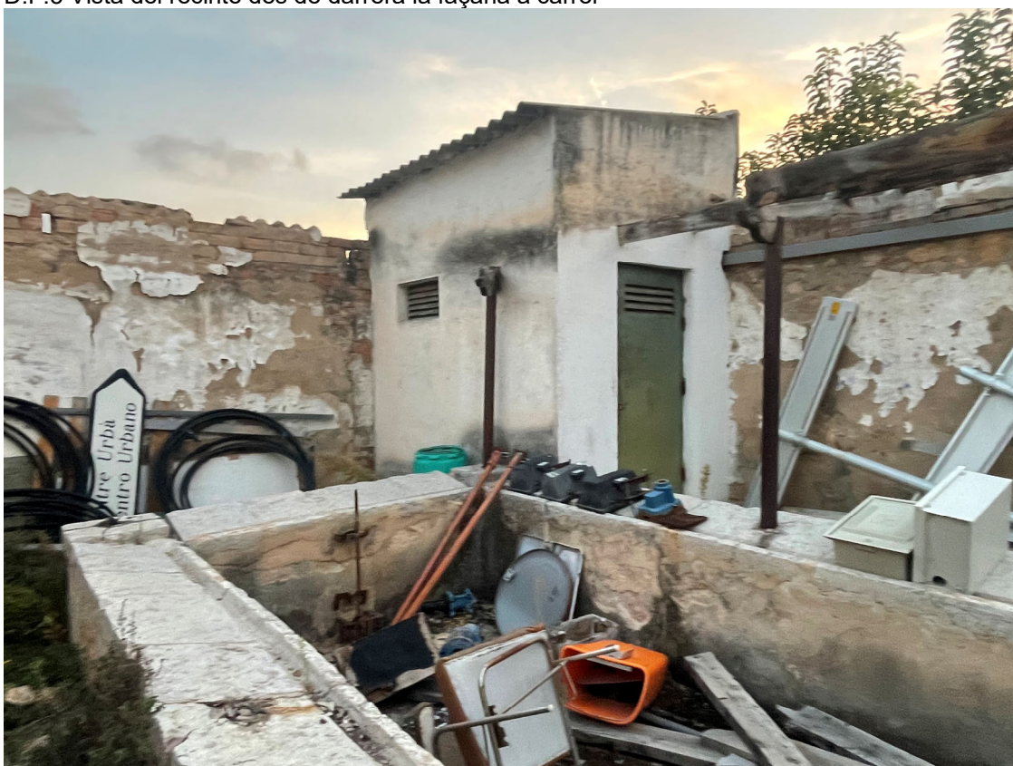
D.F.4 Façana posterior (a l'esquerra) i volum a enderrocar a la cantonada.
