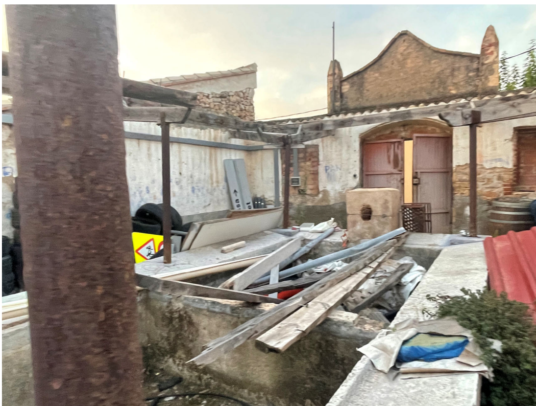
D.F.5 Vista de la bassa cap a l'accés i mitgera dreta.
