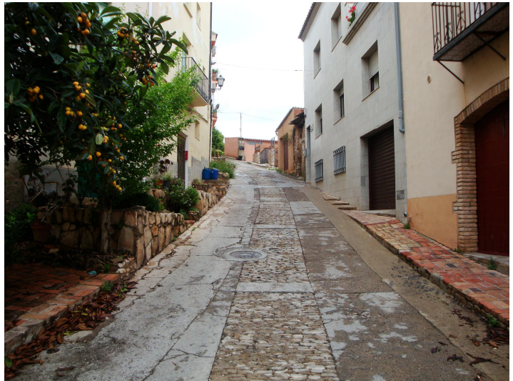
Fotografia 19: Inici c. de les Flors en sentit de pujada
