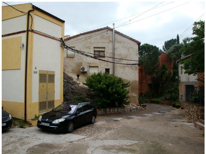
Fotografia 14: carrer Barranc d'en Pol, mirant a l'Estació Transformadora en sentit de baixada
