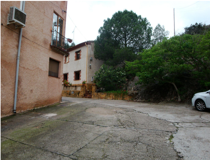
Fotografia 13: carrer Barranc d'en Pol en sentit de pujada, arribant a l'Estació Transformadora i la corba
