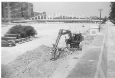
DEMOLICIÓN MECÁNICA A CIELO ABIERTO
