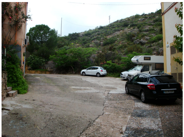
Fotografia 12: Pujada carrer Barranc d'en Pol, abans d'arribar a l'Estació Transformadora
