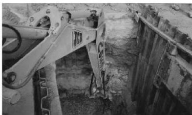
DEMOLICIÓN MECÁNICA EN ZANJA
