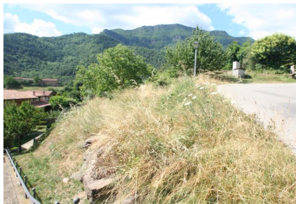
VISTA DE LA ZONA DEL DIPÒSIT
