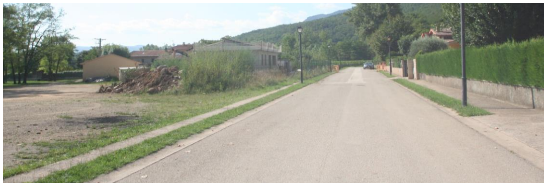
VISTA GENERAL DES D'UN ANGLE MÉS AVANÇAT
