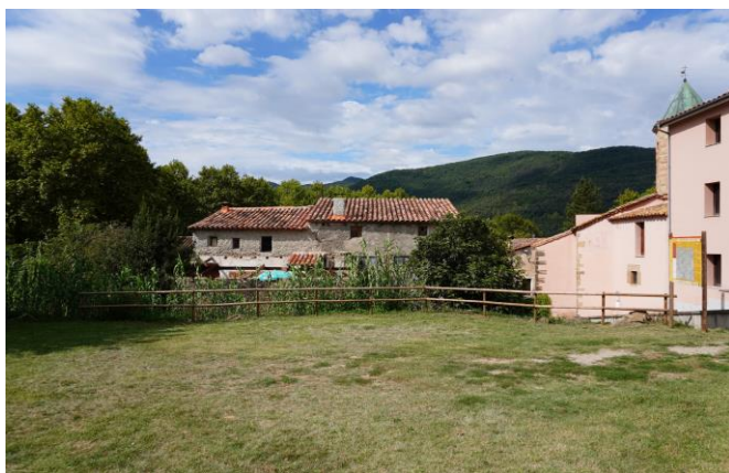
VISTA DES DE LA PART DE SOBRE DEL PÀRQUING
