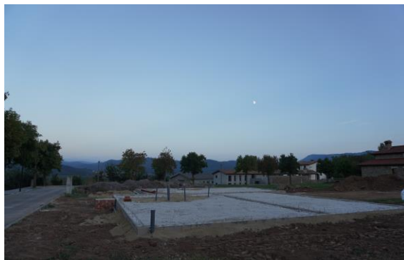
ARBRES AL VOLTANT DE LA ZONA EN CONSTRUCCIÓ
