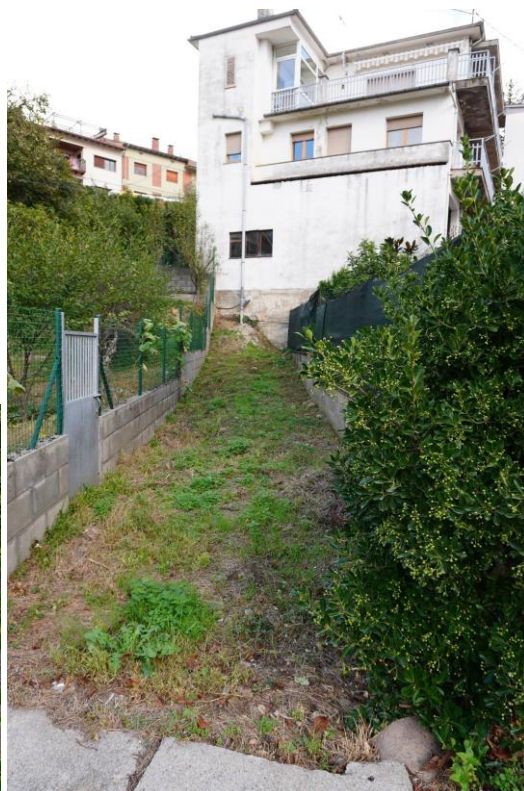
VISTA DEL Cr NO PAVIMENTAT
