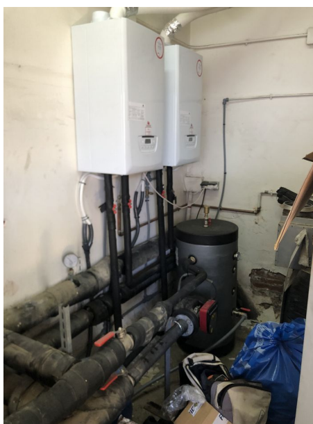
Figura 9 i 10: Calderes i bomba de circulació de la sala tècnica de Ca l'Alemany
