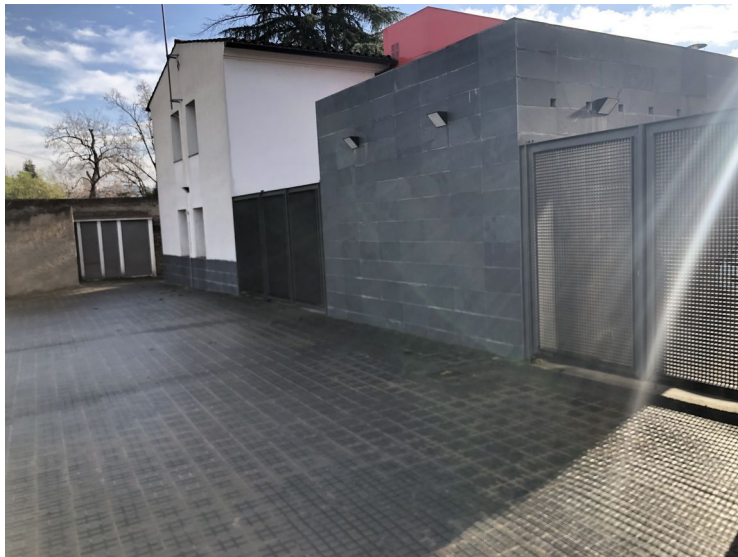
Figura 18: Sala tècnica de Ca l'Alemany
