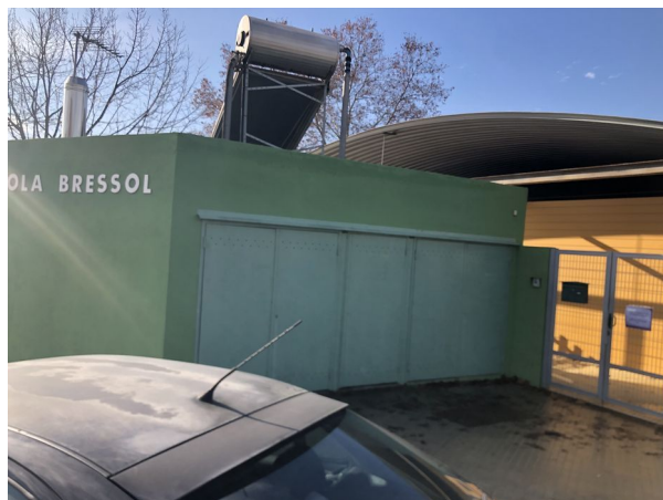
Figura 16: Façana sala tècnica Escola Bressol
