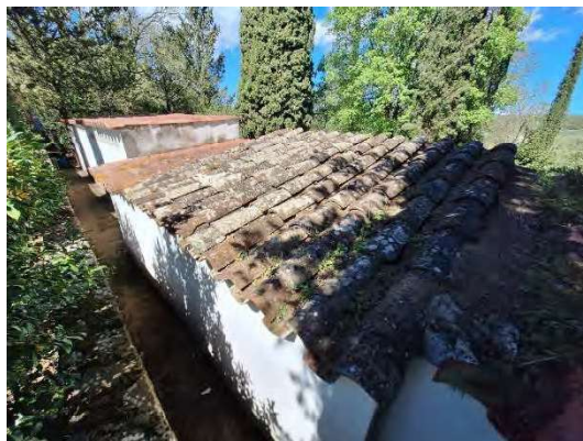
Cobertes amb poca pendent
