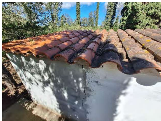
Vista de la coberta de la darrera ampliació
