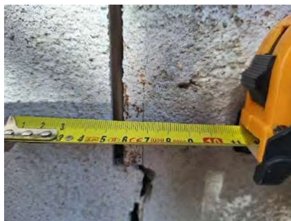
Vista de l'esquerra de la darrera ampliació de més de 6mm. d'amplada
