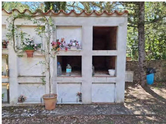
Vista parcial de la façana principal extrem nord.
