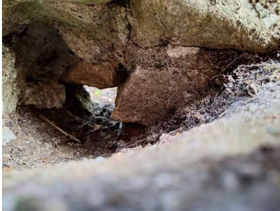
Vista del punt d'evacuació
