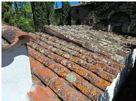
Vista de les cobertes més antigues
