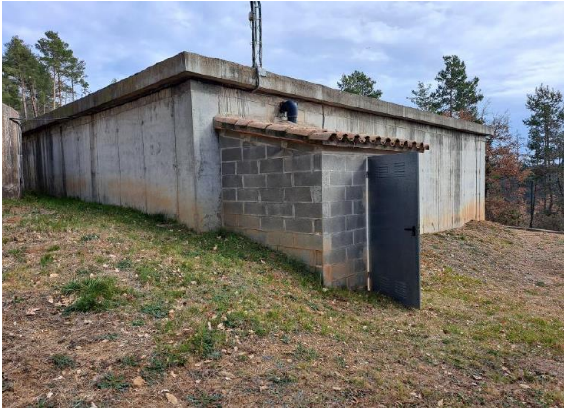
Figura 6. Caseta de cloració
