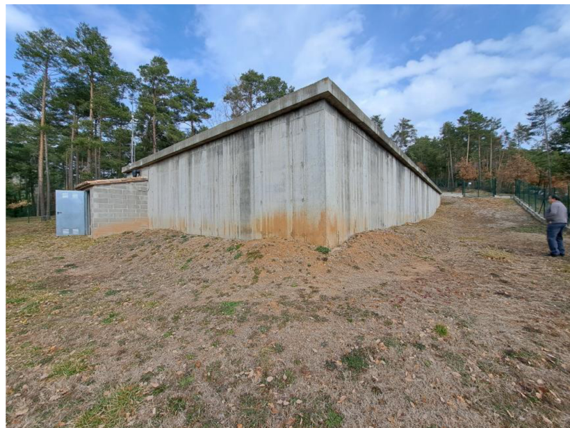
Figura 4: Dipòsit de Subirà 1 gran (aigua crua)
