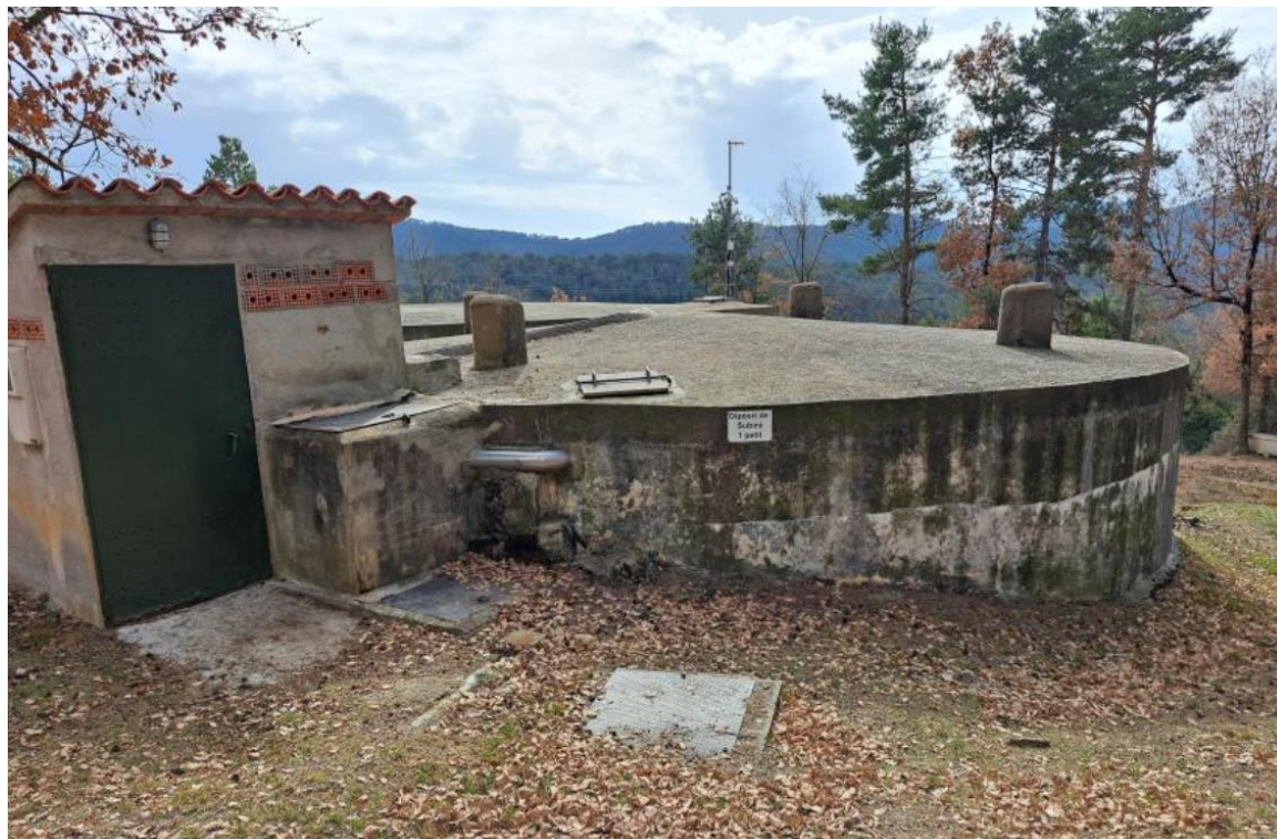
Figura 4. Dipòsit de Subirà 1 petit (aigua tractada).
