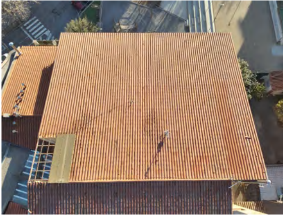
Estat actual vessant sud coberta
