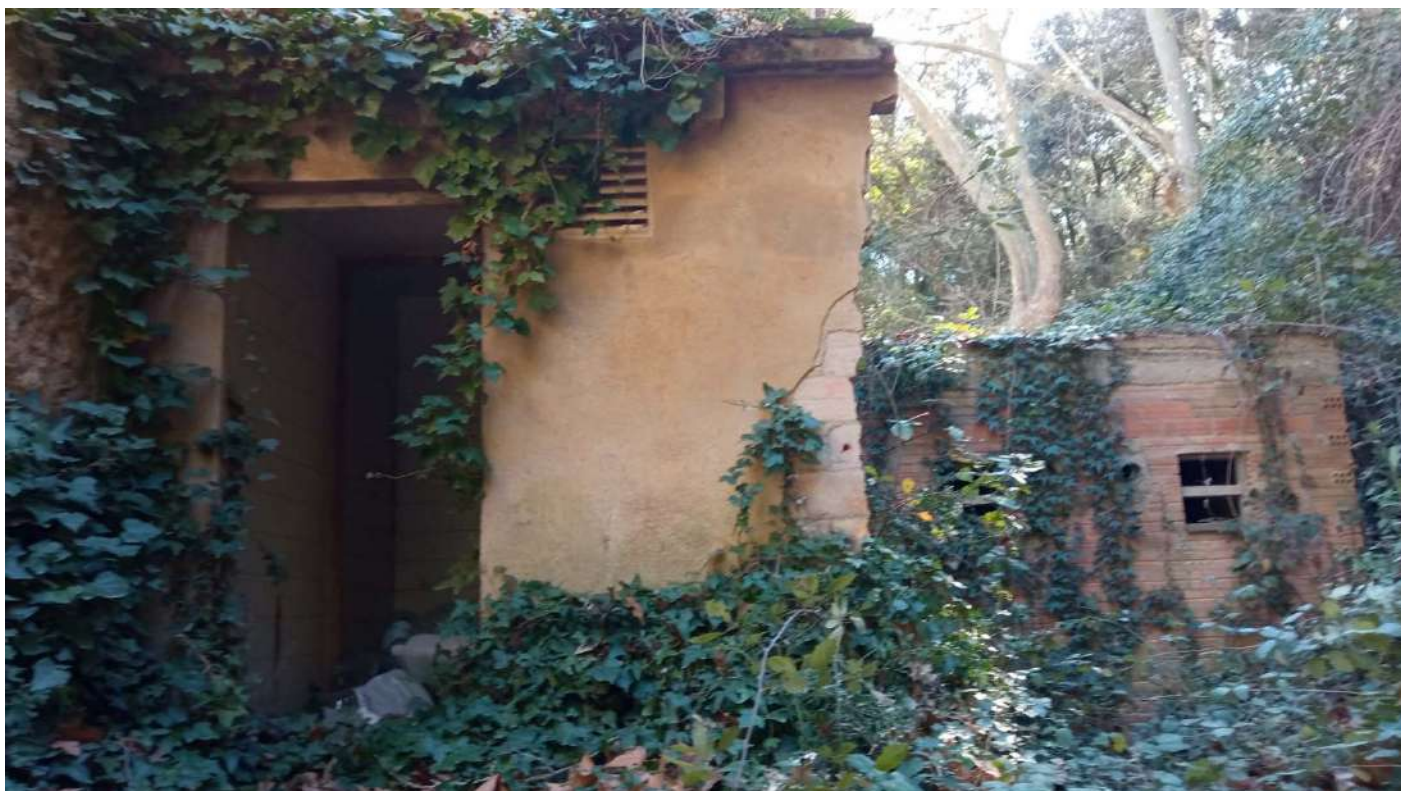
FAÇANA OEST BANY EN DESUS
