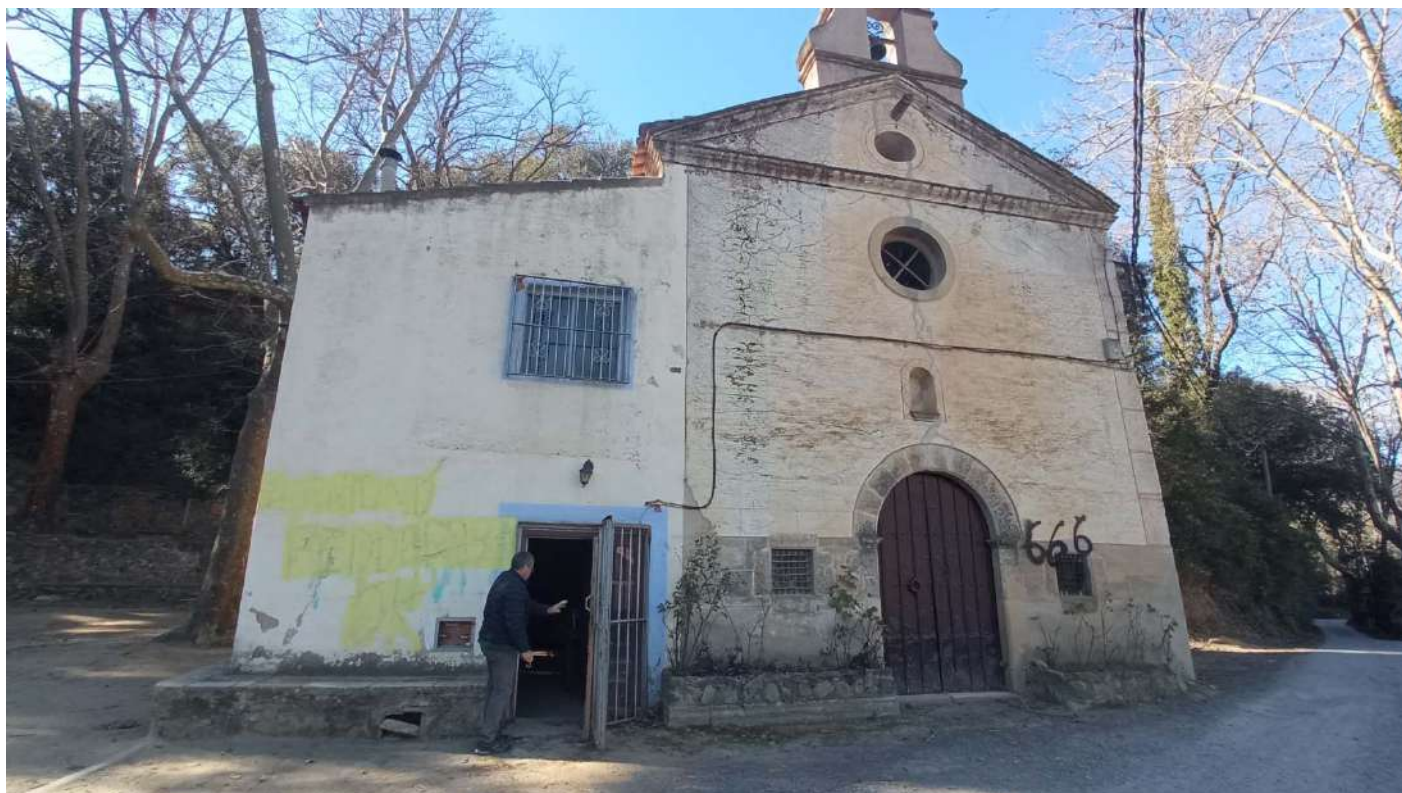
FAÇANA PRINCIPAL. FAÇANA NORT
